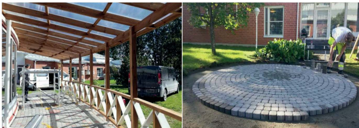
Terassin rakentaminen ja uloskäynnin toteutus sekä pyöreät pihakiveykset ajoittuivat kesälle 2017. (Kuva: Helena Raatikainen)
