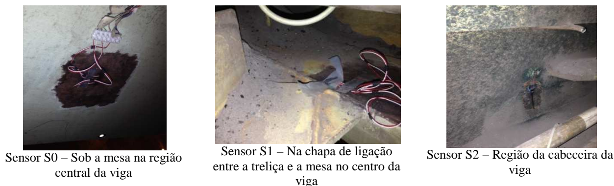
Figura 5 – Pontos da viga de rolamento monitorados por extensimetria
