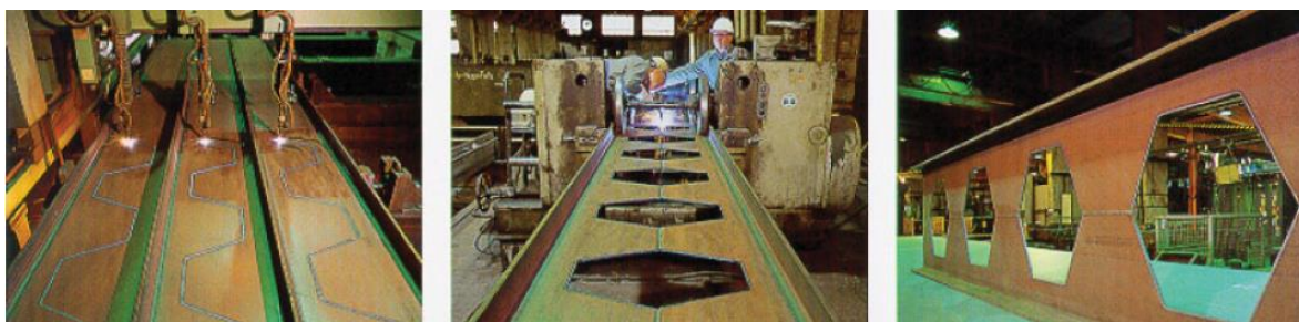
Figura 1. Fabricação de vigas casteladas de aço (Gemperle, 2007).
