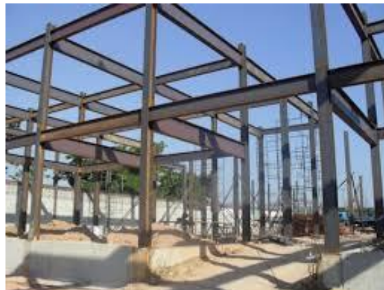
Figura 3. Montagem de uma estrutura metálica.
