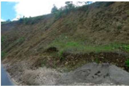
Image 6. Zone de glissement produit par la perte de forêt et l'érosion du terrain. Photographie: Teresa Tapada.
