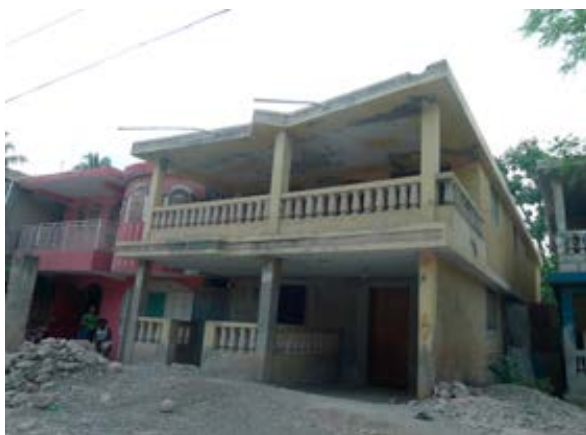
Images 23 et 24. À gauche, logement d'un étage et à droite de deux. Photographie: Teresa Tapada
