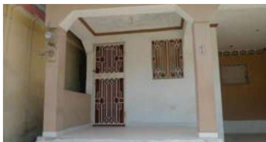
Images 54 et 55. Différentes versions de porches de logements de Mayard avec des protections contre le vol. Photographies: Teresa Tapada
