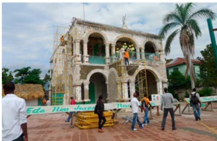
Image 13. Mairie de Jacmel actuellement en réhabilitation. Photographie: Teresa Tapada
