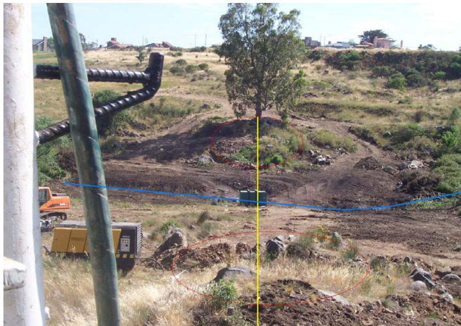
Fotografía 1 - Vista general del área de la traza del eje de la presa (primer plano área del estribo de margen izquierda – al fondo área del estribo de margen derecha)
