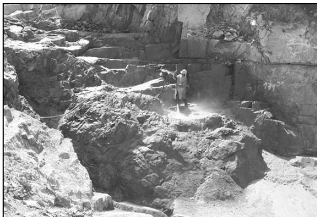
Figura 4. Limpieza de la roca de fundación mediante aire y agua a presión.
