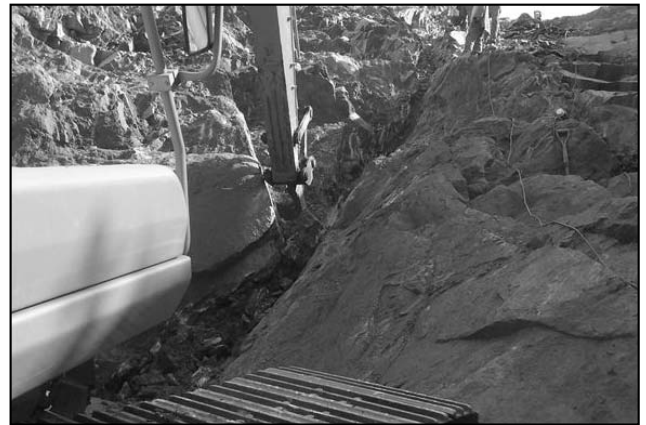
Figura 12. Saneamiento material alterado en el plano de fundación. Progresivas 125 a 150 m Zona de microfracturación y cizalla con presencia de arcillas en parte dentro de las rocas gneissicas cercana al contacto con el dique pegmatítico situado hacia aguas arriba y en parte en el contacto entre los dos tipos de roca mencionados.
