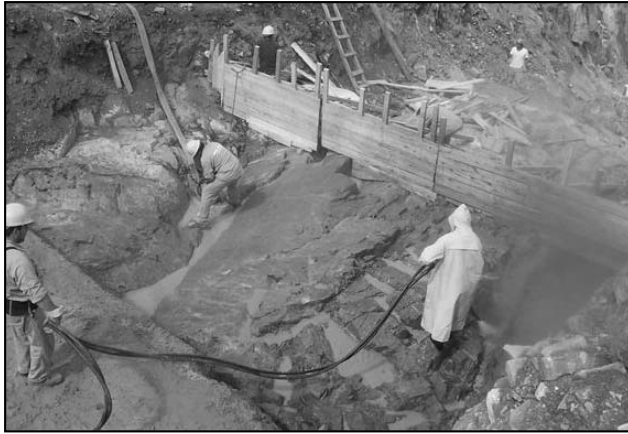
Figura 9. Vista de la fundación entre progresivas 165 y 170. Tarea de limpieza con aire y agua a presión previo al hormigonado de protección y construcción del zócalo de apoyo. Se observa dique pegmatítico en roca de caja de composición gneissica.
