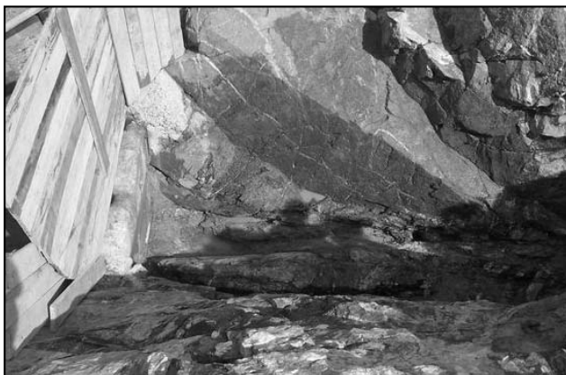
Figura 13. Sanemiento dental finalizado del contacto gneiss - pegmatita en progresivas 125 a 150m, realizado el procedimiento de lavado con aire y agua a presión previo al hormigonado de reemplazo y protección.
