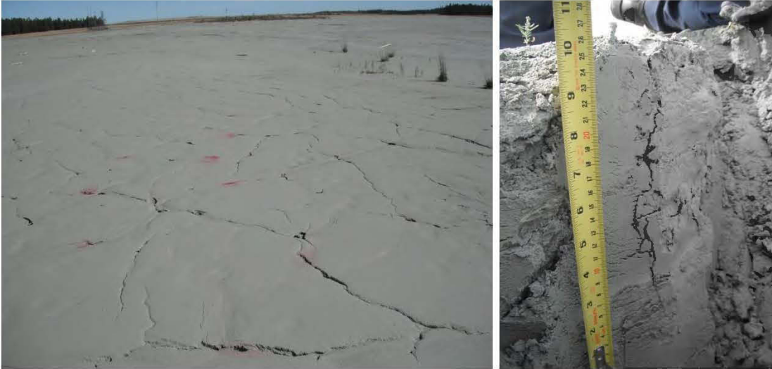
Figure 6.1 Fissures de dessiccation observées en août (gauche) ou septembre (droite) 2013 sur la couverture du parc 2 du site Manitou
