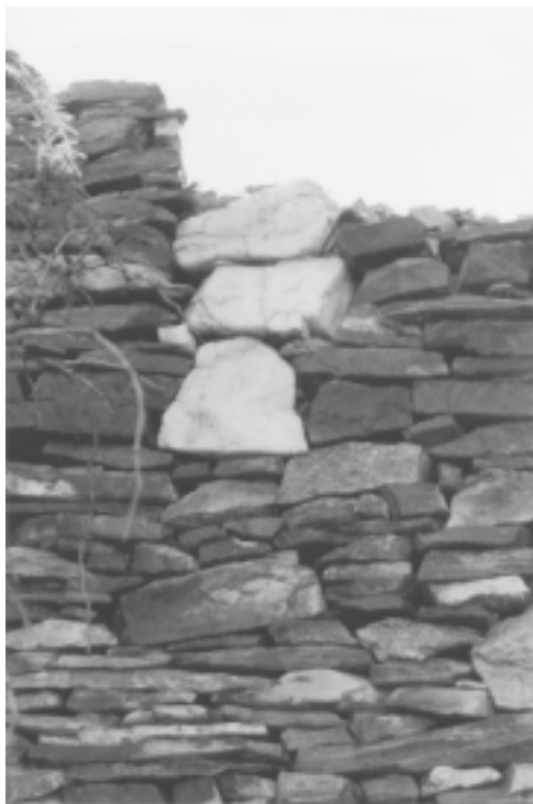
Figura 7. Muro decorado del recinto 57
