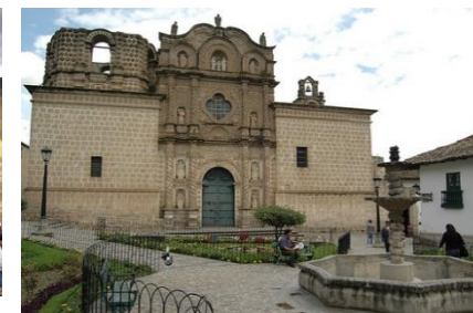
Iglesia y antiguo hospital Belén
