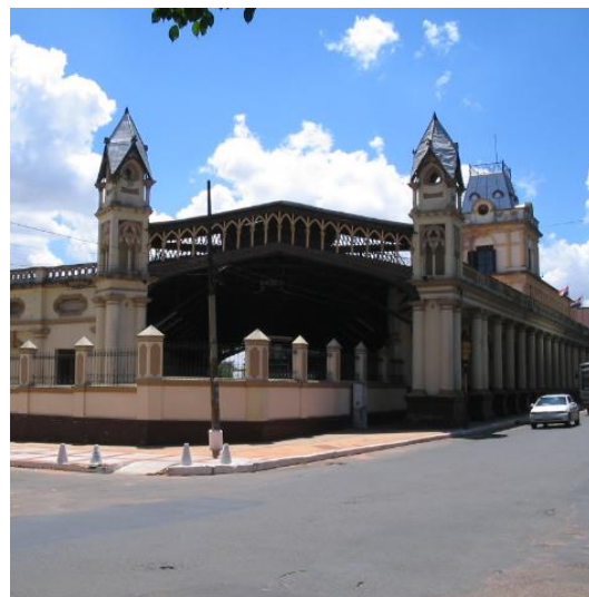
Antigua estación del ferrocarril, catalogada de valor monumental. Rehabilitada y financiada por el programa de cooperación española de escuela taller, actualmente se encuentra sin uso. Fotografía ERV Arquitectes Associats SLP.
