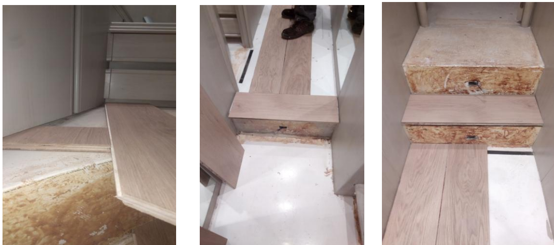
Fig. 4. 71. Muntatge del parquet (Font: pròpia)
