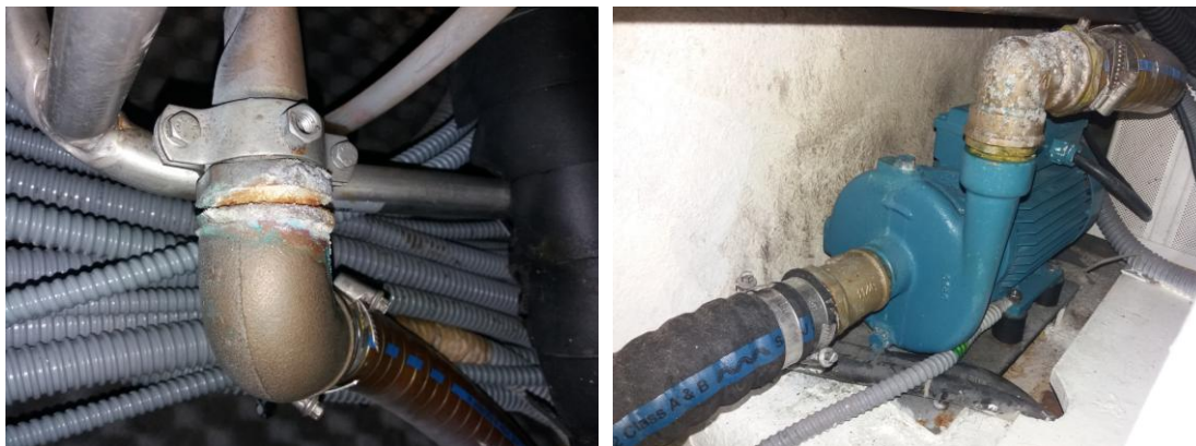
Fig. 4. 135. Pèrdues de líquids (Font: pròpia)
