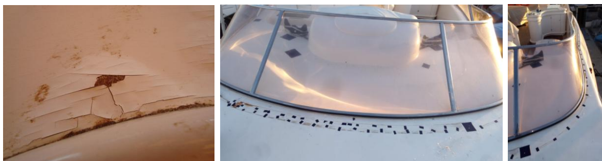
Fig. 4. 90. Entrada d'aigua a la cuina (Font: pròpia)
