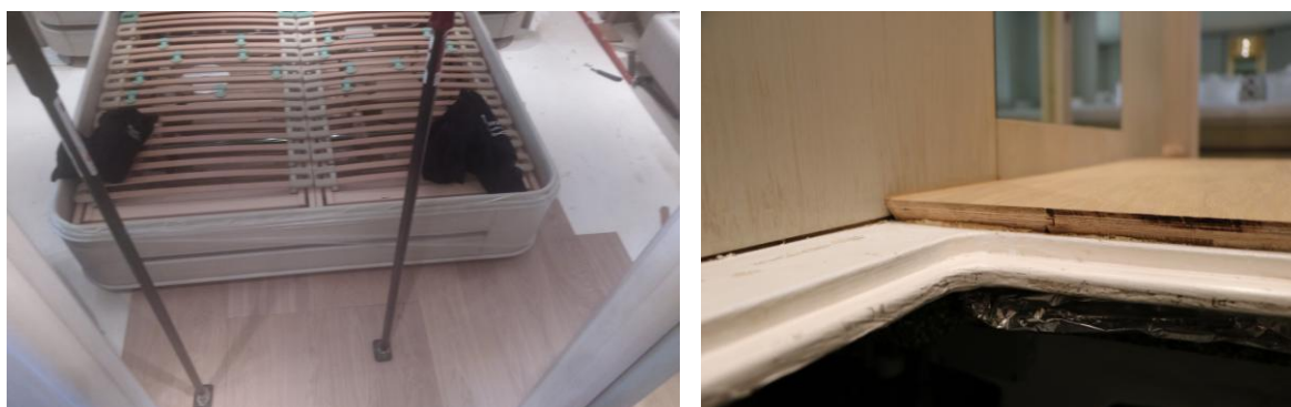
Fig. 4. 72. Muntatge del parquet (Font: pròpia)
