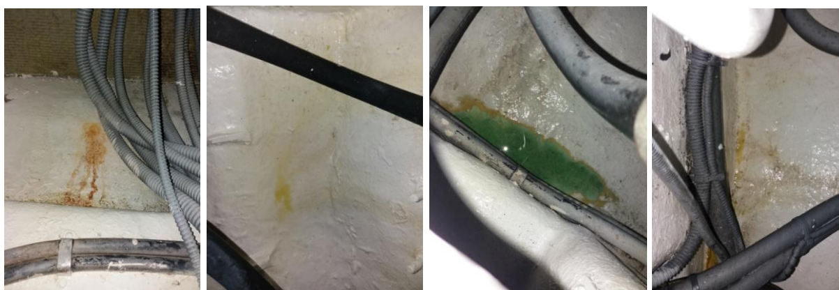
Fig. 4. 134. Pèrdues de líquid (Font: pròpia)
