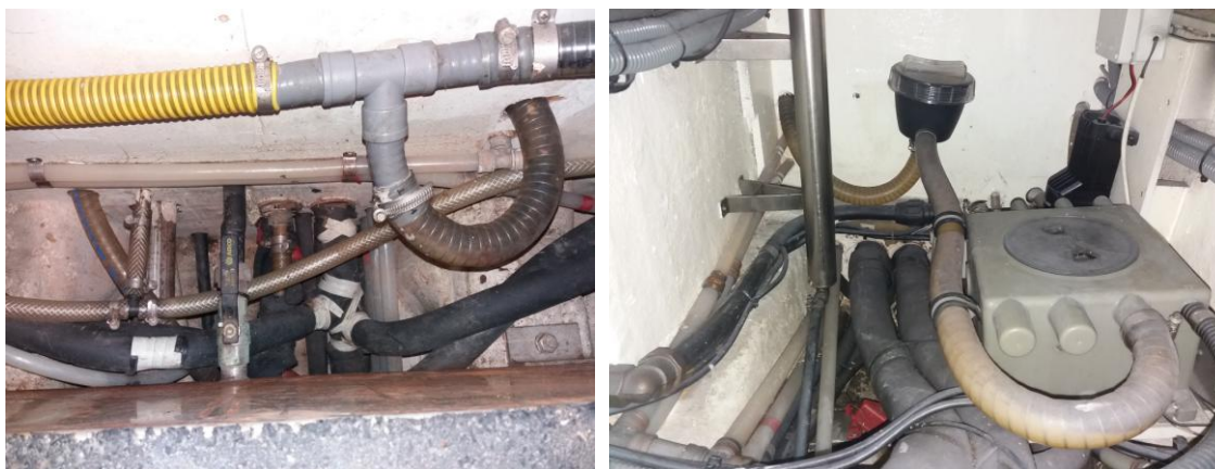
Fig. 4. 136. Circuit del desaigua de la dutxa (Font: pròpia)
