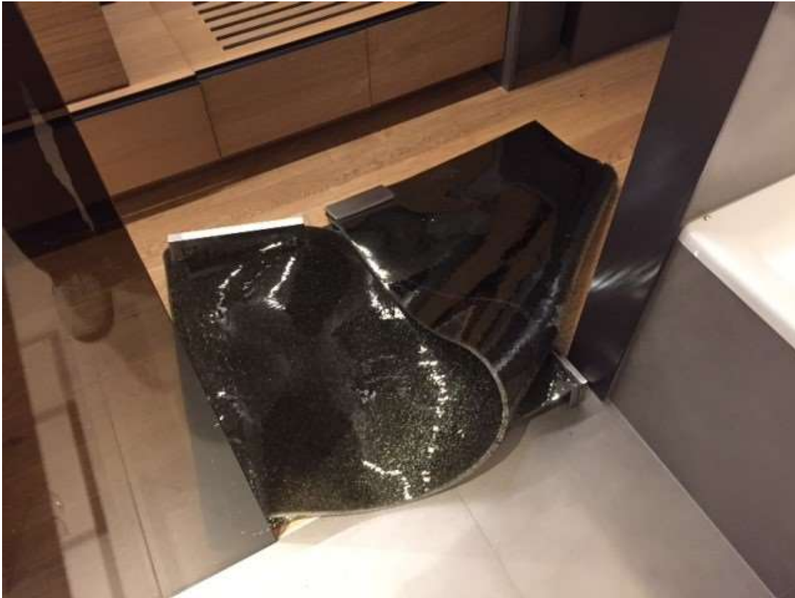
FIG. 82 - IMAGEN DE LA PUERTA ROTA. FUENTE: VIDRES BERNI
