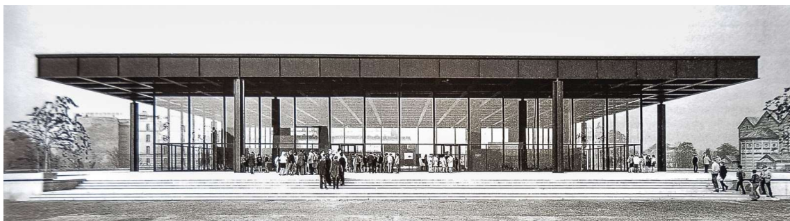
FIG. 23 - CUBIERTA Y CERRAMIENTO DE VIDRIO DE LA NUEVA GALERÍA NACIONAL DE BERLÍN. FUENTE: CORNERS OF THE 20TH CENTURY
