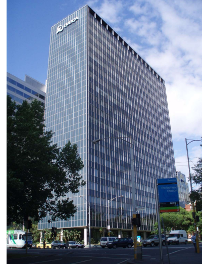
FIG. 75 - ICI HOUSE (ORICA HOUSE), MELBOURNE. FUENTE: WIKIPEDIA
