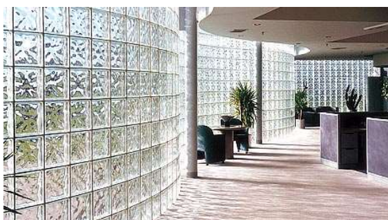
FIG. 43 - UN EJEMPLO DE APLICACIÓN DE MOLDEADO DOBLE. EN ESTE CASO SE HAN REALIZADO UNOS PARAMENTOS VERTICALES CURVADOS. FUENTE: CARPIN TECNIC
