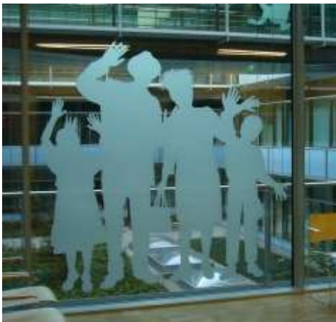
FIG. 39 - GRABADO UNIFORME AL CHORRO DE ARENA. HOSPITAL DE FRANKFURT. DISEÑO DE HEINER BLUM
