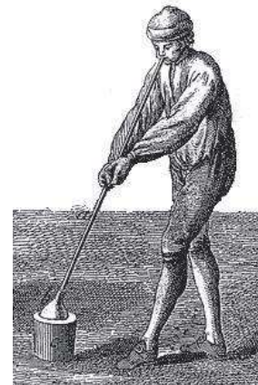
FIG. 2 - TÉCNICA DE SOLPADO. FUENTE: ENCICLOPÉDIE POR DIDEROT Y D'ALEMBERT, 1773
