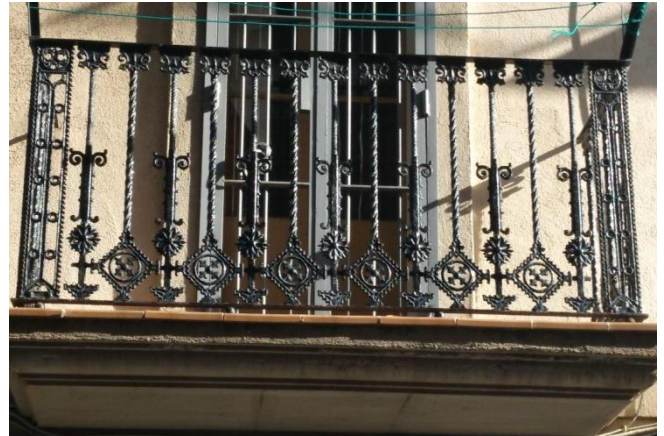
(Ejemplos de rejería de fundición, montada con remaches sobre soportaría de forja, Fotos tomadas en el barrio de la Barceloneta de Barcelona por Yaiza Garcia)
