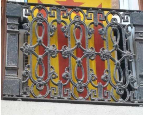
(Ejemplos de rejería de fundición, montada con remaches sobre soportaría de forja, Fotos tomadas en el barrio de la Barceloneta de Barcelona por Yaiza Garcia)
