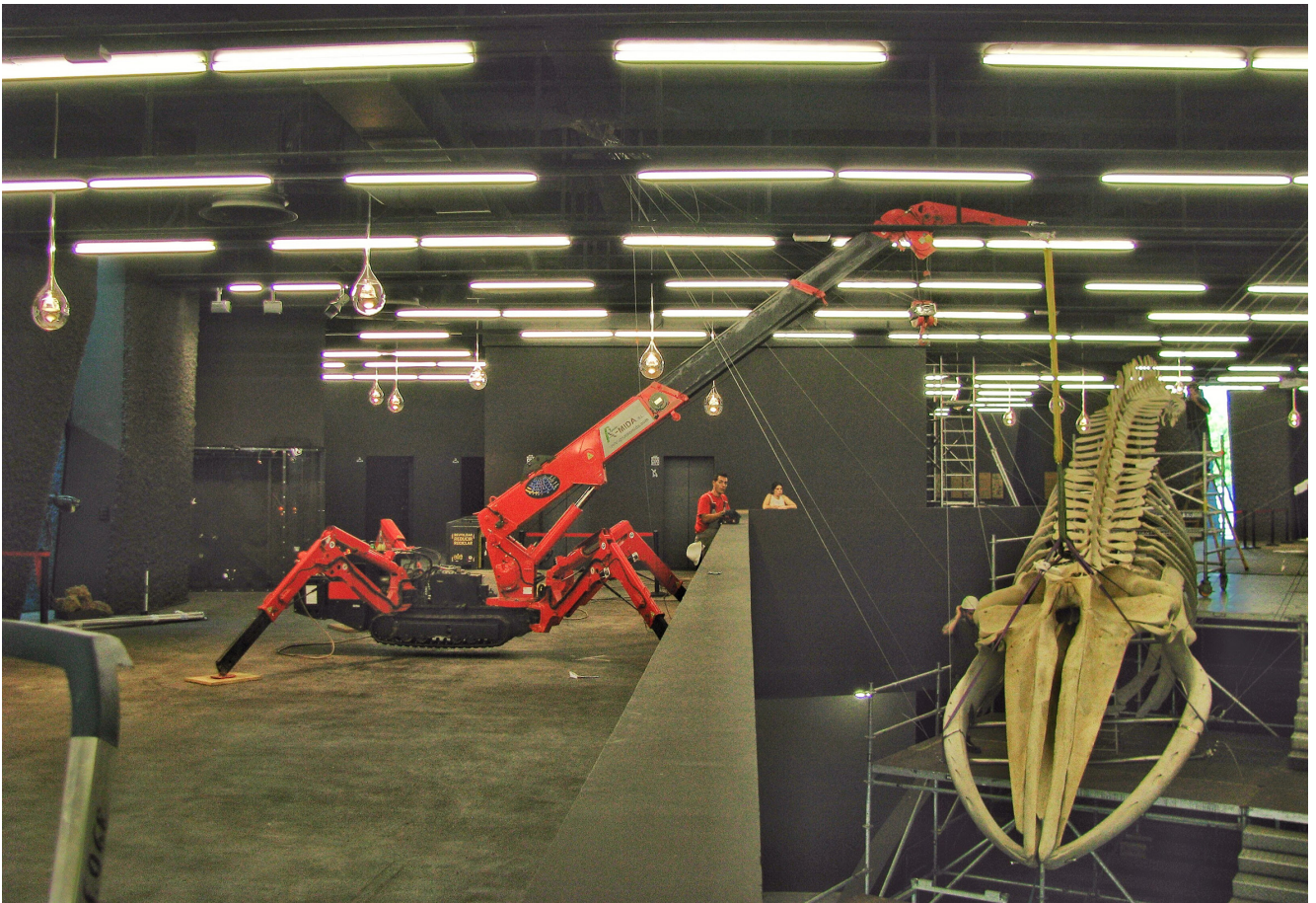
Figura 13. Proceso de montaje de la cabeza, con ayuda de una grúa fija sobre el forjado.
