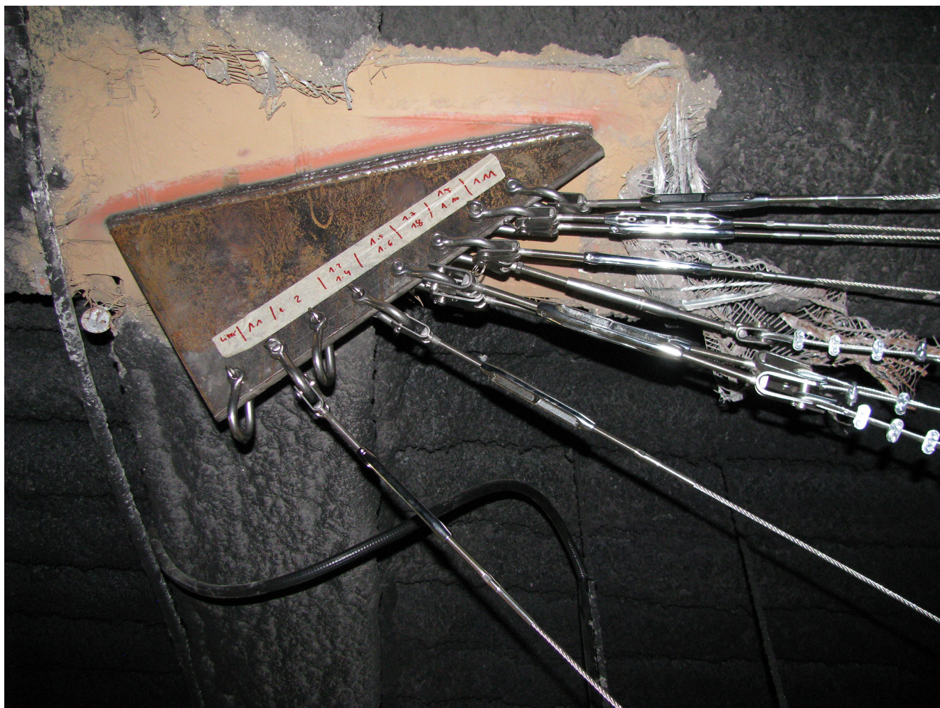
Figura 10. Una de las cuatro chapas para resolver un apoyo, soldada previa eliminación de la vermiculita.
