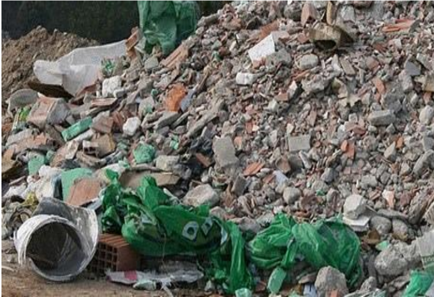
Şekil 8: Kentsel dönüşüm çalışmaları ve inşaat atıkları – molozlar (URL-12 2017)
