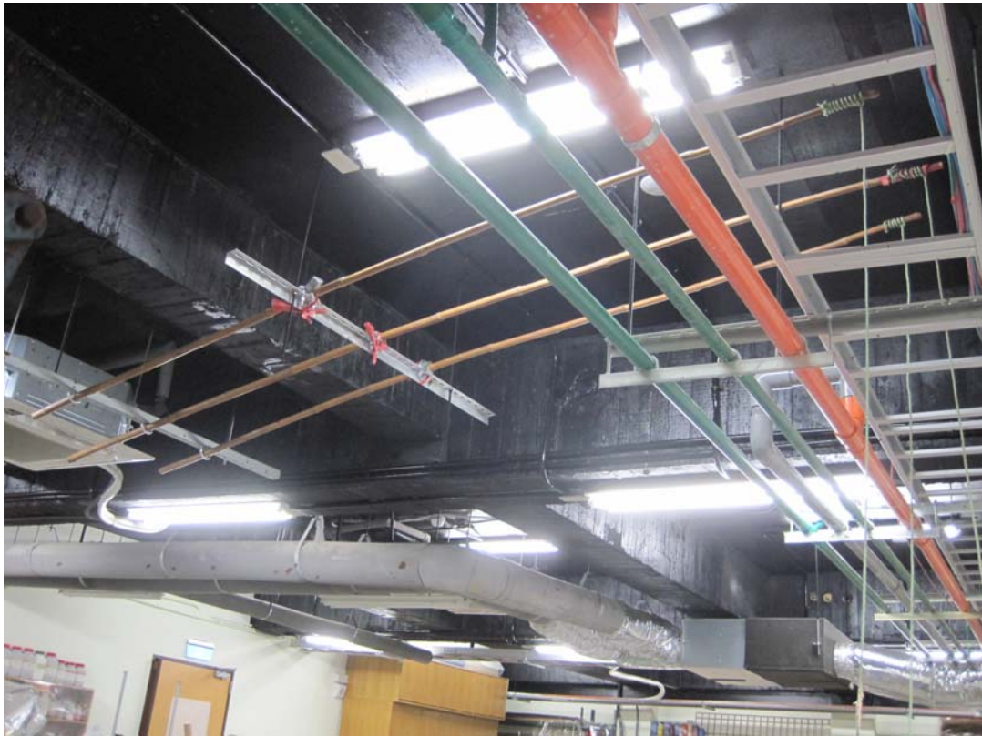
81. Se aprovecha el carácter flexible de los palos de bambú para facilitar el levantamiento del marco.
