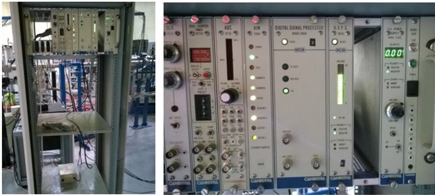
Figura 3.11: Rack con la electrónica para adquisición de datos y control del detector HPGe (izq.), y detalle de las tarjetas electrónicas HVPS 9645 y DSP 9660 (der.)
