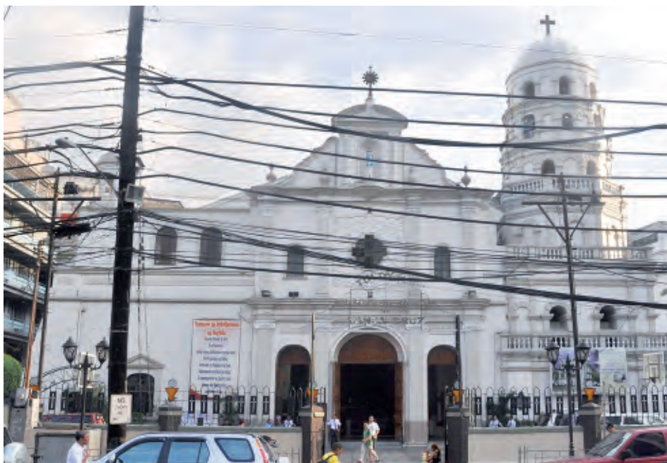
Fig. 1. Manila. Iglesia de Santa Cruz. Fachada. Estado actual.
