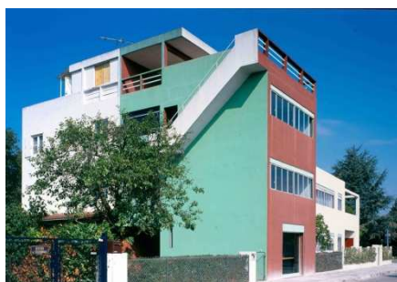
Fig.6.12. Cité Frugès, Pessac, Le Corbusier (1924). Imagen tomada en 1995. (Fuente : www.fondationlecorbusier.fr [consulta: 03.05.2015])
