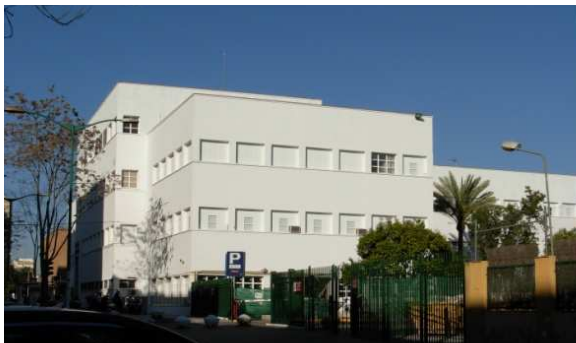
Fig.4.45. Fachada principal del conjunto desde el acceso principal, avenida Sánchez Pizjuán.
