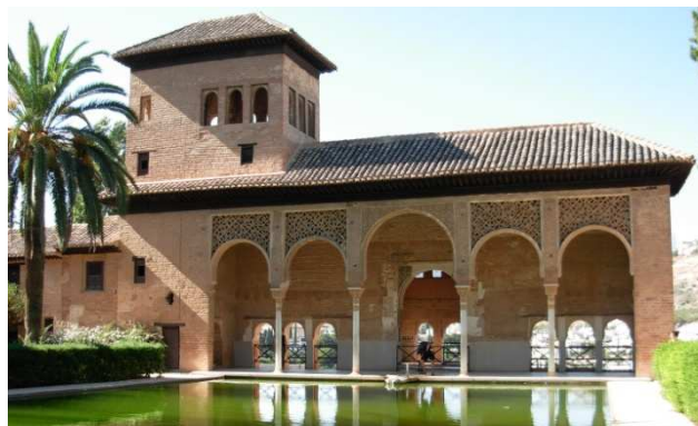
Fig.2.03. Torre de las Damas de la Alhambra, Granada. (Fuente: C. del Bosch, 2007)
