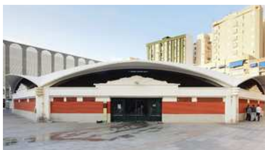
Fig.5.37 Mercado de Algeciras, Eduardo Torroja (1933).
