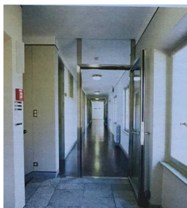
Fig.6.17. Adaptación a las medidas de seguridad en caso de incendio del Albergo Monte Verità, Ascona, E. Fahrenkamp (2004). (Fuente: G. Geronzi en Reichlin, 2014:304)
