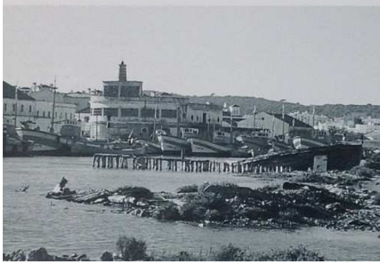
Fig.4.31. Antigua Lonja de pescado, Barbate (Cádiz), Casto Fernández-Shaw e Iturralde (1940). (Fuente: Registro DOCOMOMO Iberico, 278)
