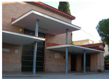
Fig.6.45. Acceso principal de la Iglesia de Santa María de las Flores y San Eugenio, Sevilla, Fernando Barquín y Barón (1962). (Fuente: C. del Bosch, 2015)
