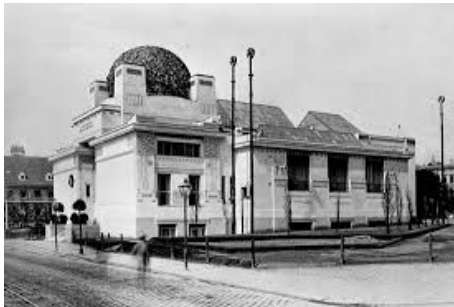
Fig.1.08. Edificio de exposiciones de la Secession en Viena, Joseph Maria Olbrich (1898). (Fuente: Gössel, 1997:649)
