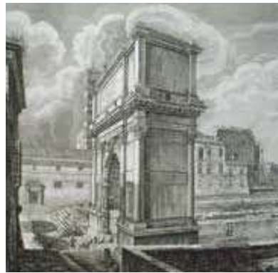
Fig.2.21. Arco de Tito, Roma, después de restauración Rossini (1819). (Fuente: Jokilehto, 1986:138)
