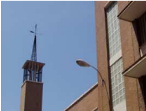
Fig.5.58. Imagen exterior del Colegio San José. (Fuente: www.docomomoiberico.com [consulta: 24.02.2015])
