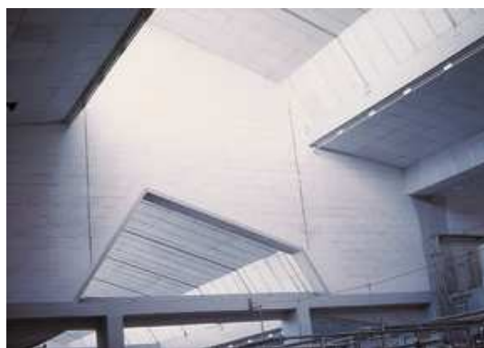
Fig.4.20. Interior de Central Lechera CLESA, Madrid, Alejandro de la Sota (1958-1966). (Fuente: www.docomomoiberico.com [consulta: 12.02.2017])
