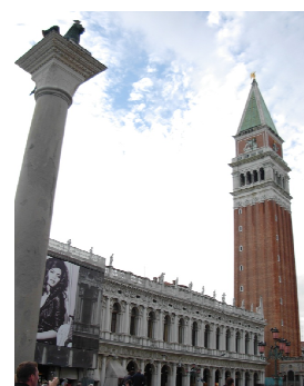
Fig.2.42. Campanile de plaza San Marcos, Venecia. (Fuente: C. del Bosch, 2010)
