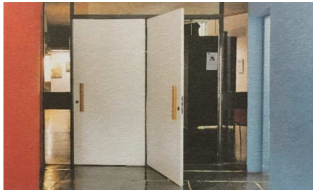
Fig.5.36. Maison du Brésil, Le Corbusier, Paris (1958). Actualización de los accesos ( la porte papillon ) realizada por Rio y Bauchet en 2000. (Fuente: Bauchet, 2014:277)
