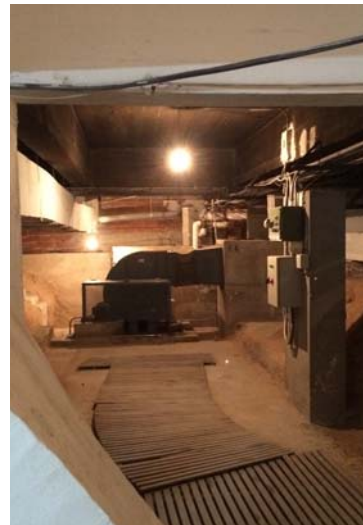
Foto 30: Salida de conductos hacia impulsión en suelo a hall de salón de conferencias.
