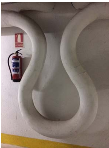
Fotos 16 y 17: Liras de dilatación para el uso de calefacción y válvulas de purgado.
