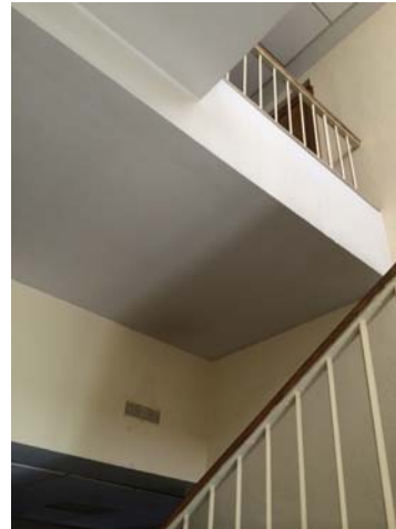
Fotos 39 y 40: Planta intermedia para transporte de conductos de aire y otras instalaciones.
