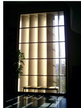
Figura 7.68. Lamas móviles verticales
