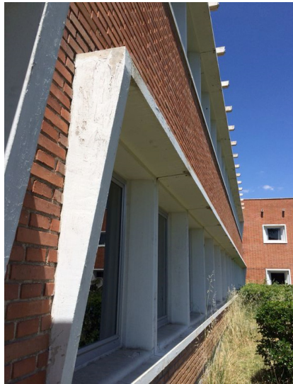
Figuras 7.66. y Figura 7.67. Voladizo para protección solar en huecos, y lamas fijas horizontales, respectivamente.
