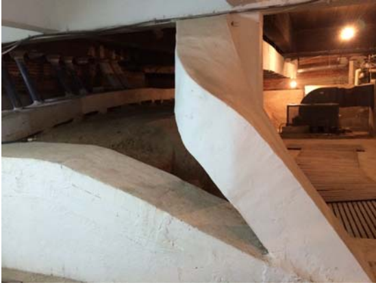
Fotos 32 y 33: Adecuación de trazados de conductos y cruce con otras instalaciones.
