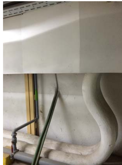
Foto 28: Trazado homogéneo de conductos de aire. Foto 29: Cruce de trazados.
