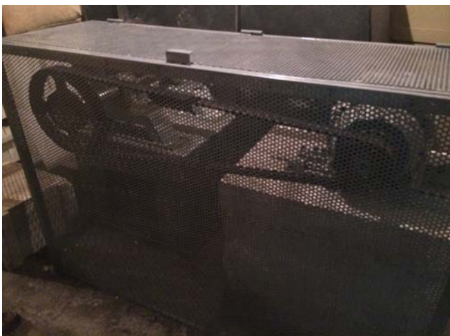
Fotos 22 y 23: Bombas y cuadro eléctrico de climatizador con protección posterior.
