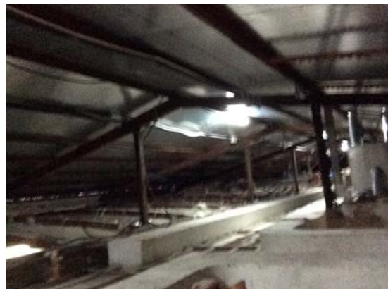
Fotos 39 y 40: Planta intermedia para transporte de conductos de aire y otras instalaciones.
