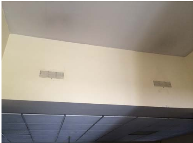
Fotos 39 y 40: Planta intermedia para transporte de conductos de aire y otras instalaciones.
