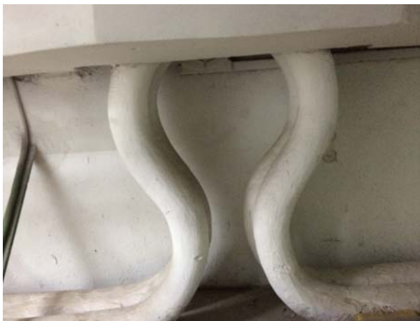
Fotos 18 y 19: Solución puntual de encuentros con elementos y cambio de trazado.
