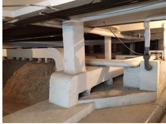
Fotos 32 y 33: Adecuación de trazados de conductos y cruce con otras instalaciones.
