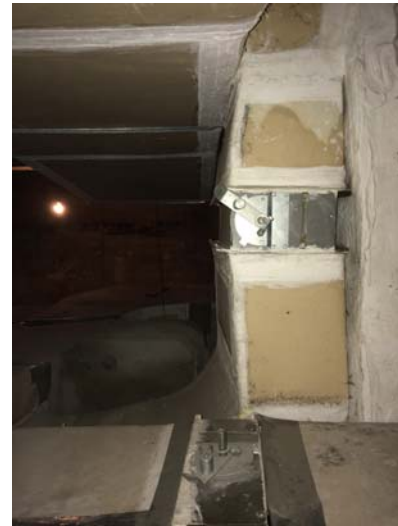
Foto 37: Cabina de climatizador en sótano. Foto 38: Compuerta manual en conducto.
