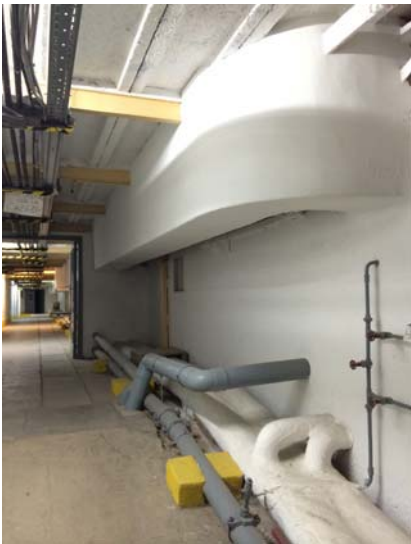
Foto 28: Trazado homogéneo de conductos de aire. Foto 29: Cruce de trazados.
