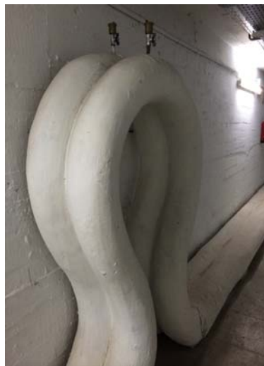
Fotos 16 y 17: Liras de dilatación para el uso de calefacción y válvulas de purgado.
