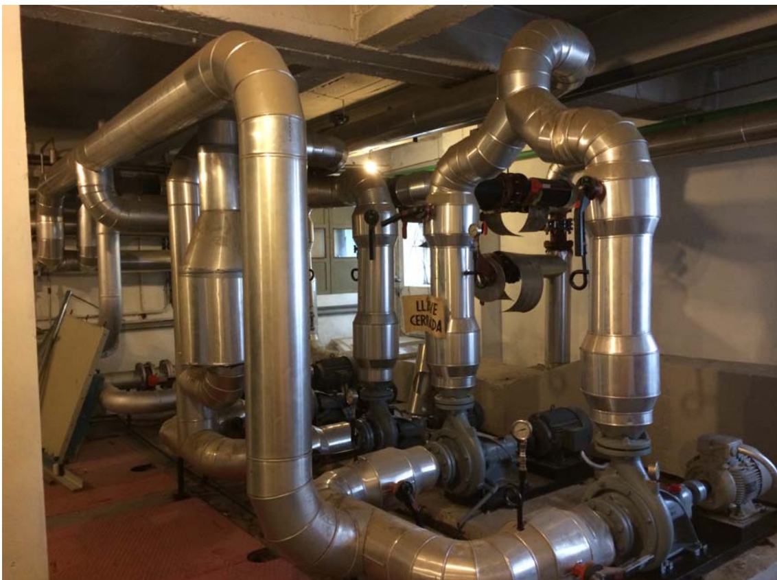
Foto 7: Sistema by-pass para cambiar la producción según las necesidades de confort.
