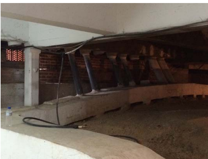
Foto 30: Salida de conductos hacia impulsión en suelo a hall de salón de conferencias.
