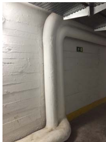
Fotos 18 y 19: Solución puntual de encuentros con elementos y cambio de trazado.
