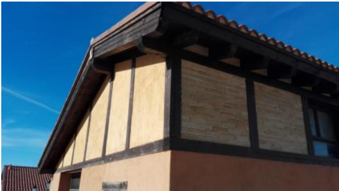
Figura 45. Protección efectiva. MAD-002. Cubierta volada.
