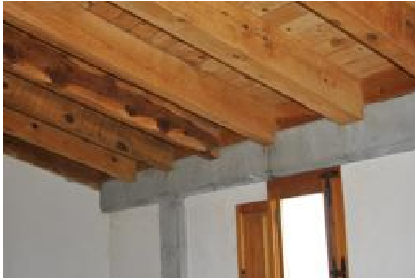
Figura 54. Vivienda en Renedo de la Vega (PAL-002) realizada con estructura de hormigón armado. Fuente: Autor.
