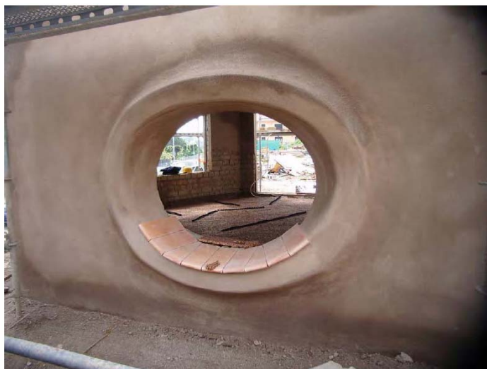
Figura 84. Ejecución de uno de los huecos. Tipo ovalado con pieza cerámica. Fuente: Proyecto Escuela.
