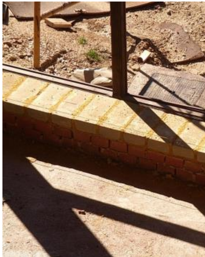
Figura 31. Elevación del BT. MAD-002. Utilización de ladrillo cerámico. Fuente: Jorge Seisdedos.
