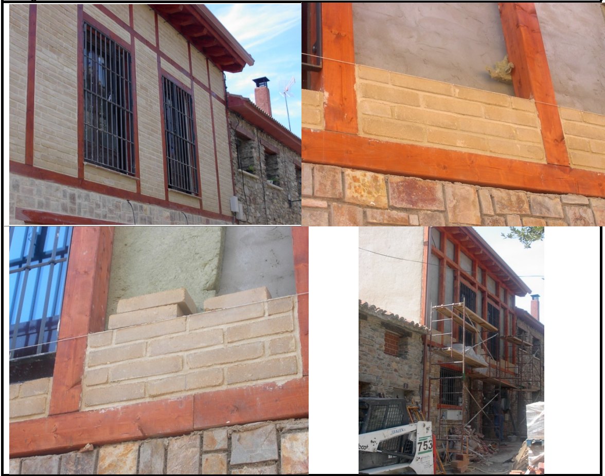
Imágenes. Fotos de obra. DF.
