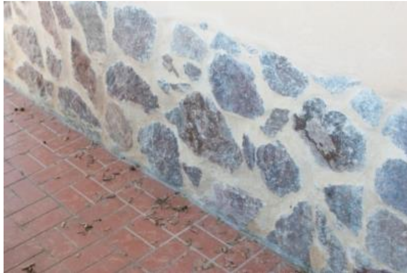
Figura 26. Sobrecimentación SEV-001. Fuente: Autor.
