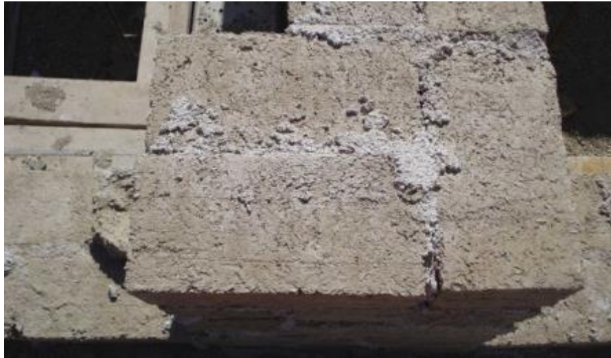
Figura 48 Muro y aparejo. Fuente: Cannabric. La Tenada (Almería). ALM-001
