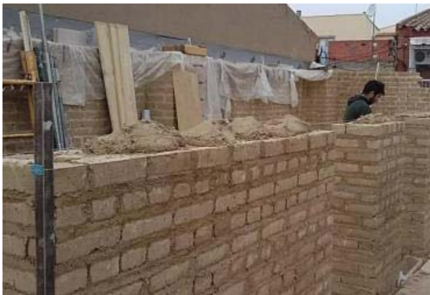
Figura 49. Espesor con doble hilada (ZAR-001). Fuente: Pedro Bel Anzue.
