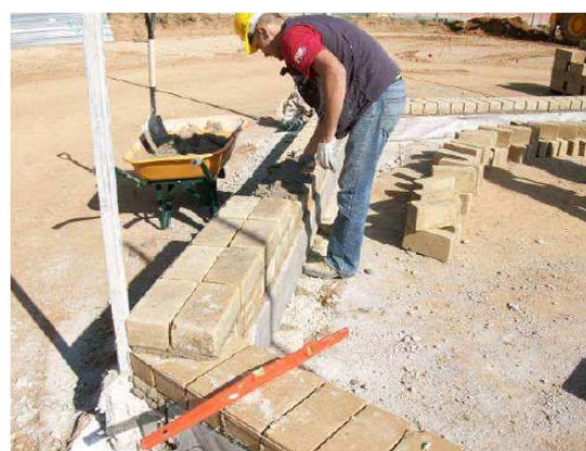
Figura 85. Detalles de coronación de muro y base. Fuente: (Barbeta et al., 2012)
