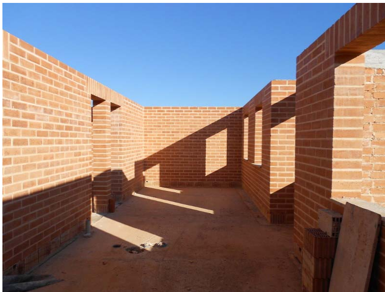
Figura 55. Vivienda unifamiliar en Lutmajor (BAL-001) con muros portantes. Fuente: Eduardo Ramos (Ecocreamos).
