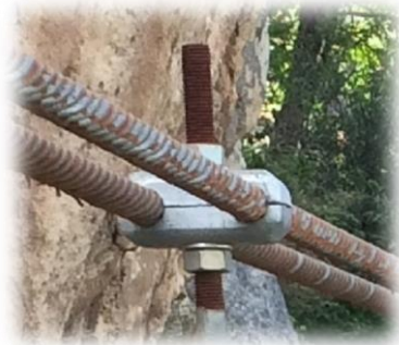
Figura 5.5. Unión entre cables y péndolas en la parte superior. Fuente: Elaboración propia.
