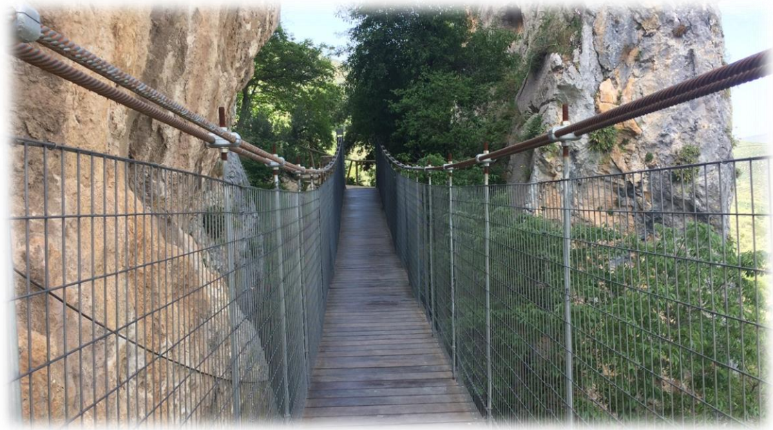
Figura 5.4. Vista de la pasarela desde el interior. Fuente: Elaboración propia.
