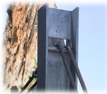
Figura 5.6. Detalle de unión entre cables y vigas de los extremos de la pasarela. Fuente: Elaboración propia.
