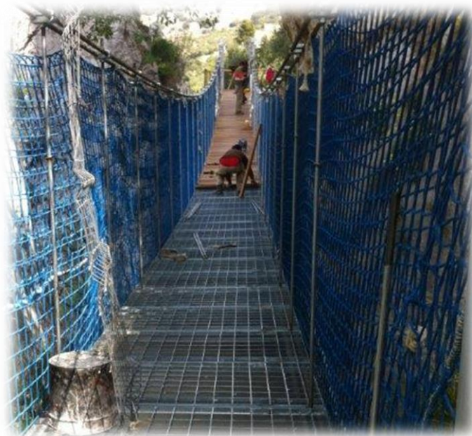
Figura 5.3. Colocación de trámex y madera en el tablero de la pasarela. Fuente: Metalhergos S.L.
