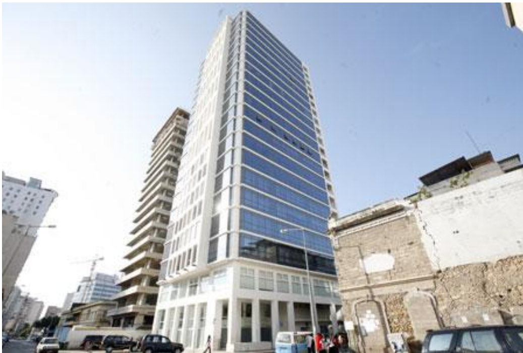
Fig. 62 – Novos edifícios em altura na Baixa de Luanda – contrastes do edificado
