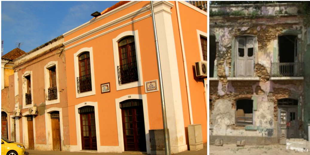
Fig. 74 e 75 – Edifícios do tipo sobrado, recuperado e em estado de degradação
