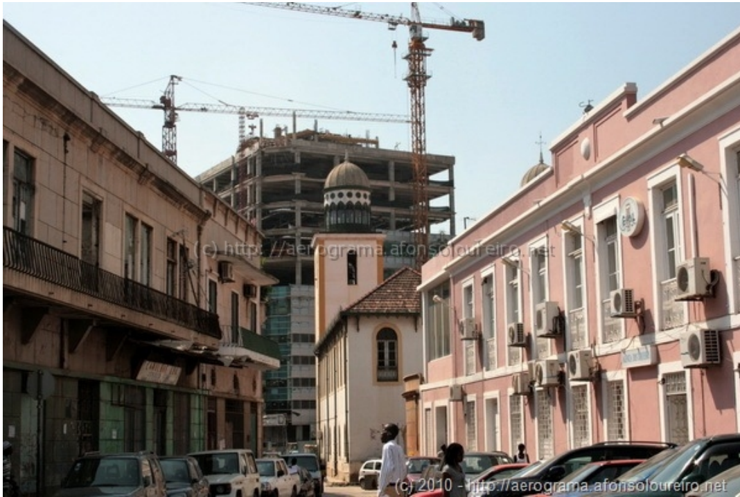
Fig. 78 – Edifício sede da EPAL e traseiras da Igreja da Sé
