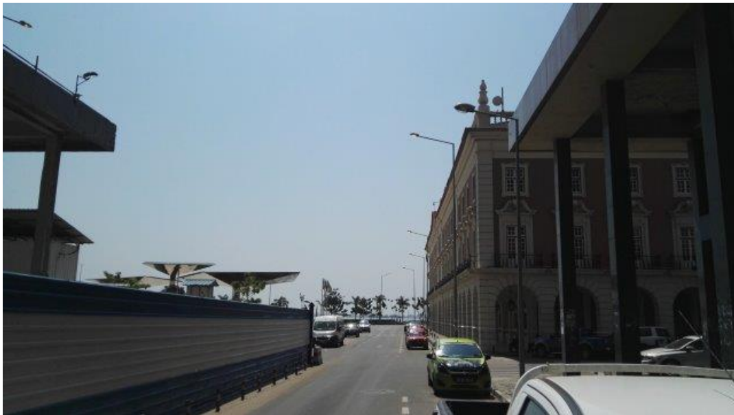
Fig. 65 – Vista do edifício do Banco Nacional de Angola (à direita) e edifício do Museu da Moeda (à esquerda) com enfiamento visual para a Av. 4 de Fevereiro
