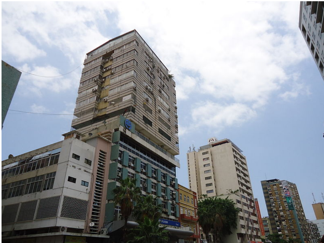
Fig. 45 – Rua Rainha Ginga – Vista de parte do edificado
