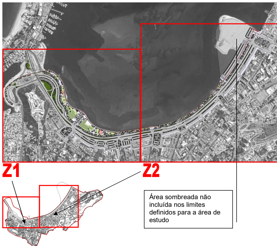
Fig. 6 – Vista aérea de toda a Baía de Luanda e recente intervenção
