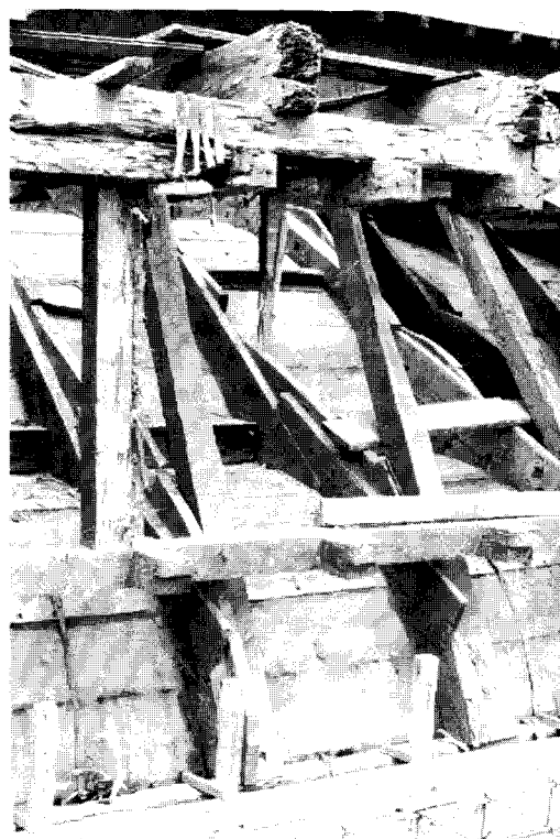
Figura 2 Vista en la que se aprecia la estructura paralela de soporte del cerramiento de quincha , también se aprecia las cabezas de las vigas madres, segundo plano cerchas
