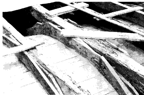
Figura 4 Vista de la parte superior de las cerchas paralelas sujetas a las vigas madres. Se aprecia la parte superior del intrados y restos del lienzo que sellaba las uniones
