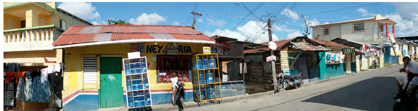
fig. 27. Estado de la edificación las viviendas: en azul son las que están construidas con materiales peores, paredes de madera o chapa de acero y techos de madera y chapa. fig. 28. Viviendas productivas dando a la calle José María García.
