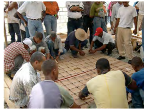
< figs. 62 a 67. Técnica Peruana de forjados formado por viguetas y duomos de hormigón prefabricados in situ y muro de quincha Peruana mejorada.
