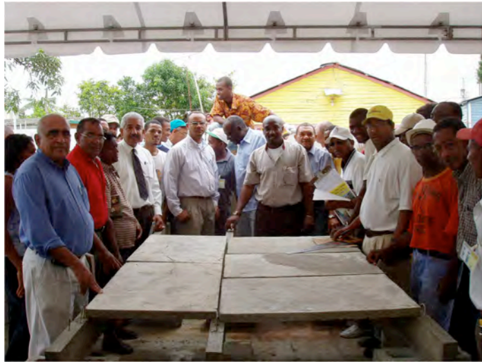
212 fig. 72. Montaje de la tecnología, plaqueta y vigueta, donde se ven las dos posibilidades de montaje: con entrevigado de 90 cm para cubiertas, y con entrevigado de 60 cm para forjado de piso.
