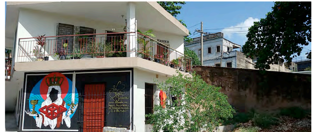
fig. 16. Vivienda de estilo moderno en el fuerte del Angulo Santa Bárbara.
