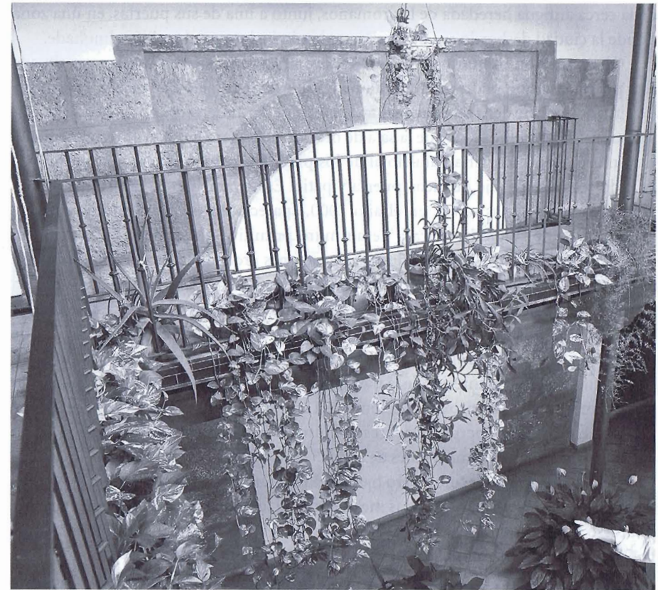
FIG. 3. Puerta de acceso desde el patio.
