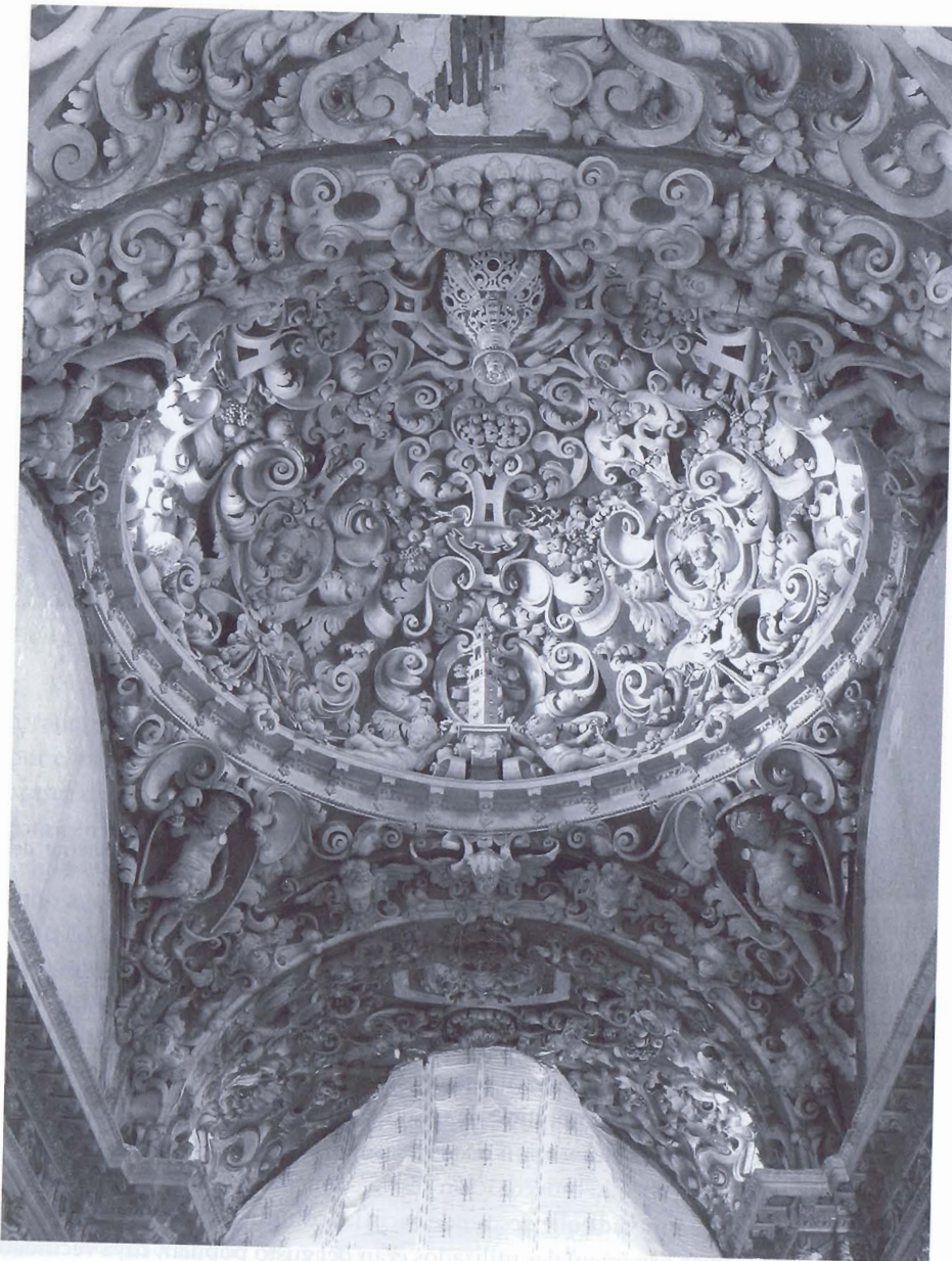
FIG. 15. Vista de la cúpula desde la nave de la iglesia.
