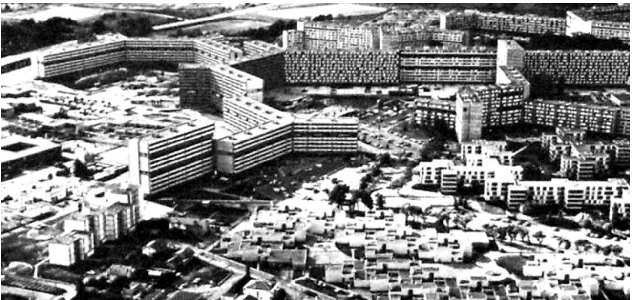
Figura 2. Bellefontaine, vista de los tres tipos de edificios residenciales, equipamientos y edificios docentes, sobre 1972. Fuente: Candilis-Josic-Woods, 1976, p.107.
