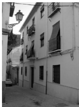
227] Estado inicial y final de la fachada. Fuente: Oficina de Rehabilitación del Albaicín, EPSA.
