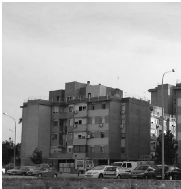
259] Bloques en rehabilitación. Foto: Surco Arquitectura.
