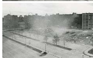
68] Fotogramas de la demolición de Pruitt-Igoe, 1972. Fuente: Wikipedia
