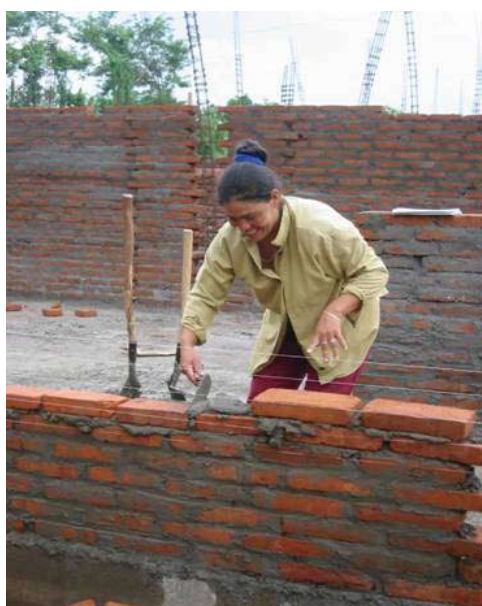
84]Maestra nicaragüense participando en la autoconstrucción de las viviendas de su barrio. Foto: ACS
