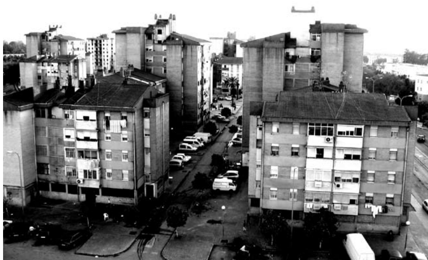
230] Vista de la barriada Martínez Montañés. Foto: Surco Arquitectura.
