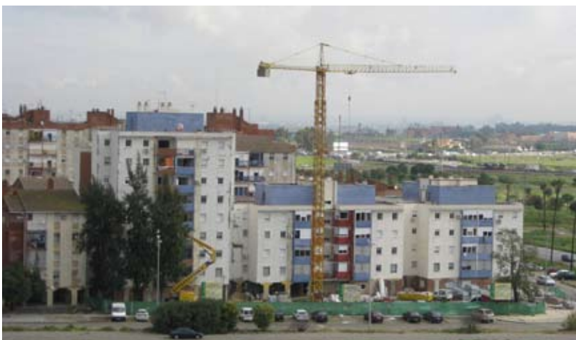
269] Obras en el Conjunto 7. Foto: SurcoArquitectura.
