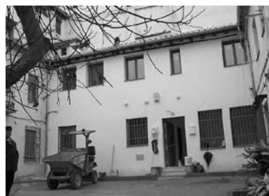
222] Estado inicial y final de la fachada. Fuente: Oficina de Rehabilitación del Albaicín, EPSA.
