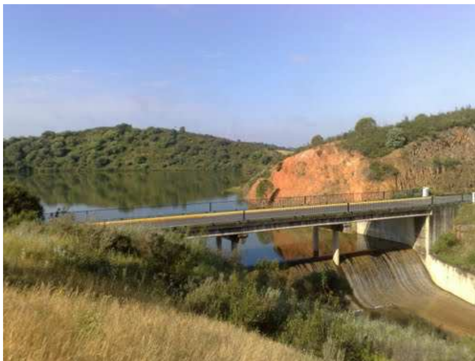
Ilustración 1-2. Aliviadero de la Presa del Corumbel.
