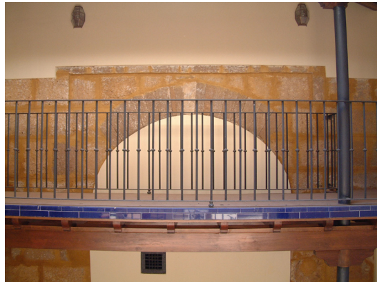
Fotografía 2. Puerta de acceso desde el patio.
