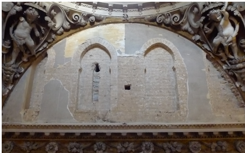
Fotografía 1. Tímpano del falso crucero con las ventanas descubiertas.
