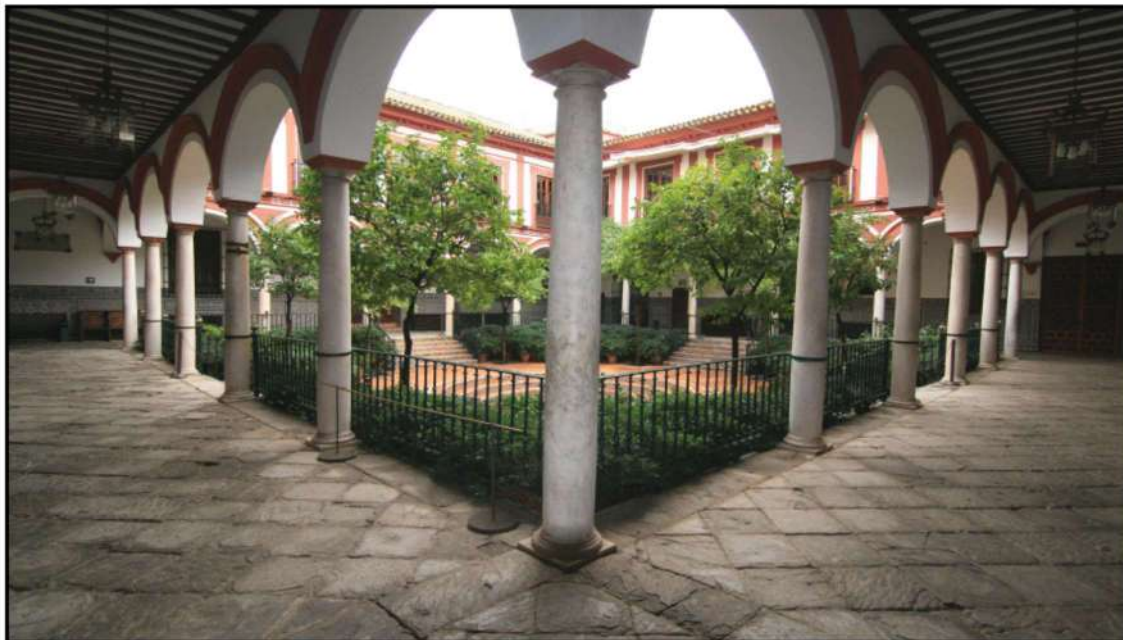
DETALLE GALERÍAS PATIO 2
