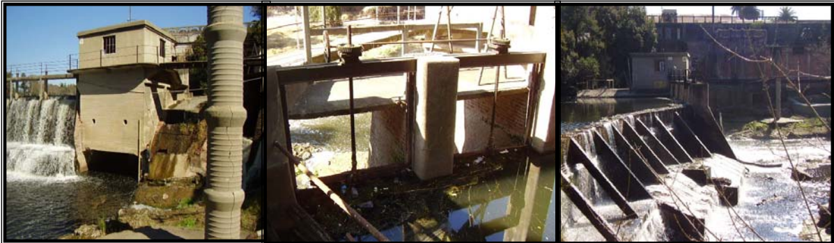
Fig. 8. Vista fotográfica de la presa.
