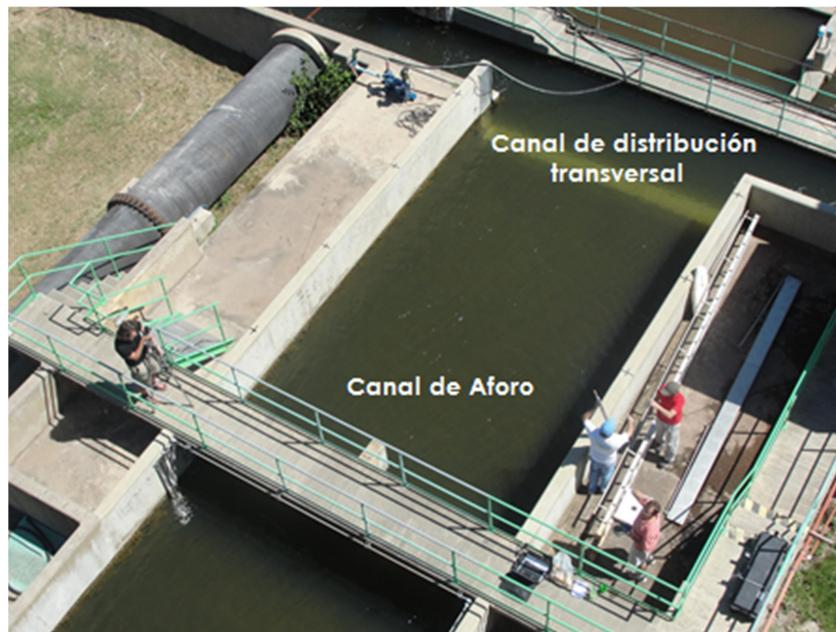
Figura 1.2.- Canal de Aforo y Canal de distribución transversal de la Planta de tratamiento de agua potable "Los Molinos". Córdoba, Argentina.
