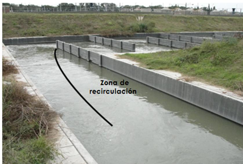
Figura 1.3.- Canal de Aforo a la salida de la planta de tratamiento de aguas residuales "Bajo Grande", Córdoba, Argentina.
