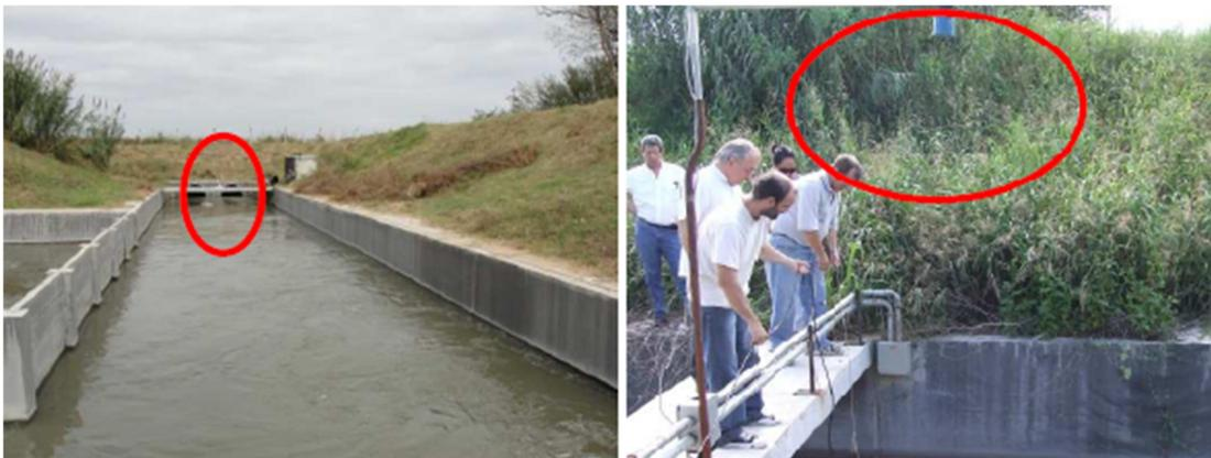
Figura 1.5.- Sensor de nivel instalado en el canal de aforo de la planta de tratamiento de aguas residuales "Bajo Grande".
