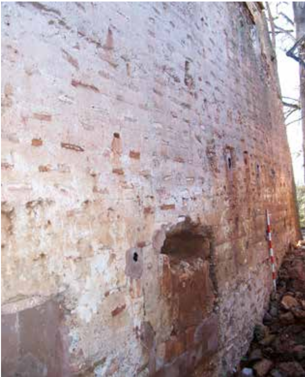
Figura 162. Pany de tàpia valenciana conservat en una alqueria.
