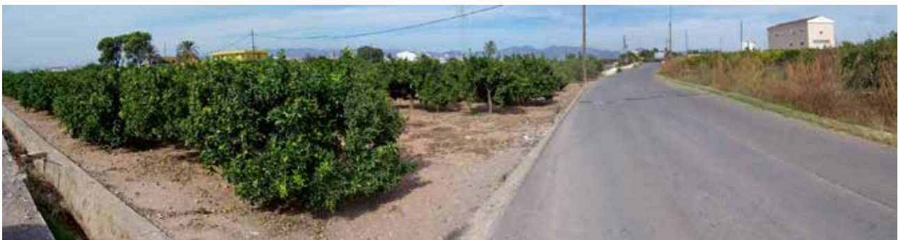
Figura 211. Panoràmica de l'emplaçament a la vora del Caminàs.
