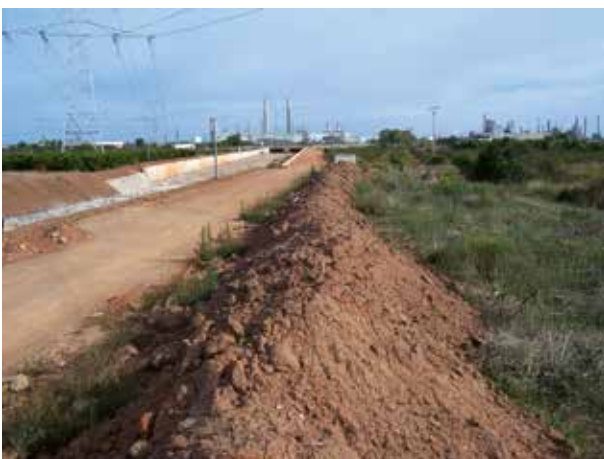
Figura 201. Vista de la zona oriental de l'emplaçament.
