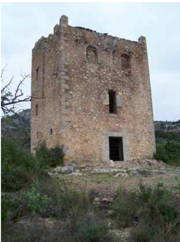
Figura 169. Façana principal de la torre.
