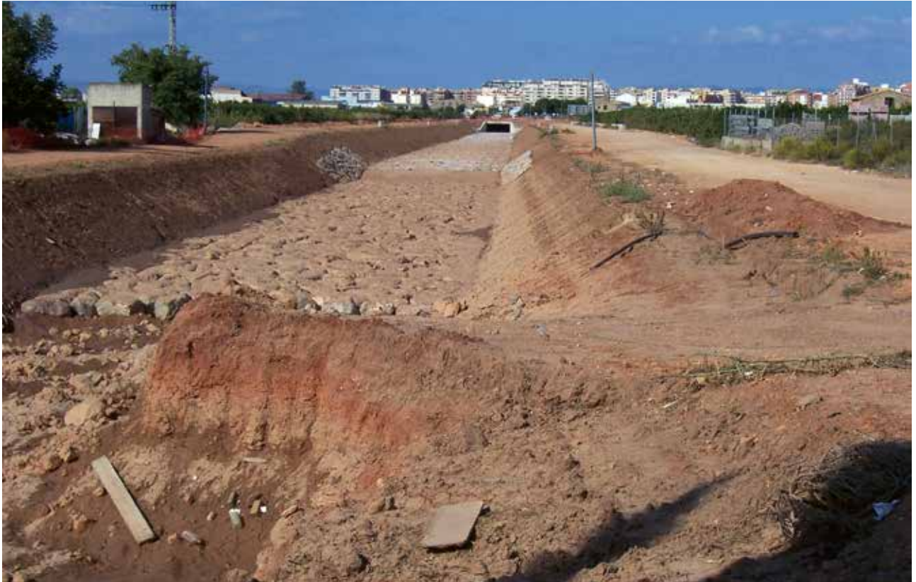
Figura 22. Vista dels treballs de construcció de la nova canalització del barranc de Fraga, entre la ronda Est i el Caminàs, en 2010.
