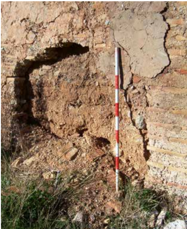
Figura 33. Estructures construïdes reutilitzades per altres edificacions a la partida d'Almalafa.
