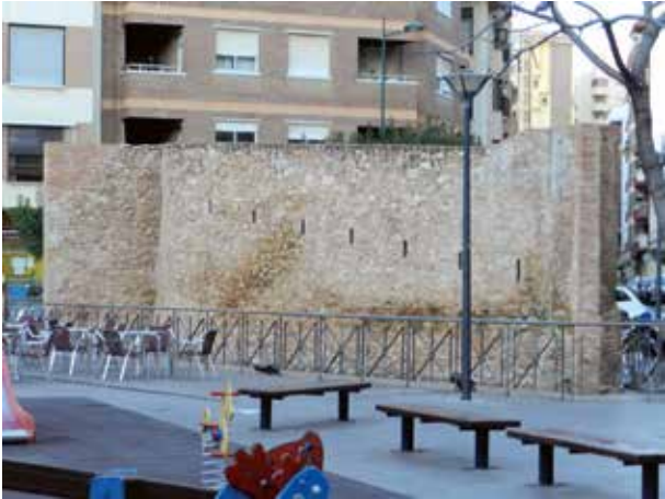
Figura 302. Llenç de la muralla recuperat i conservat a la plaça de la Muralla.
