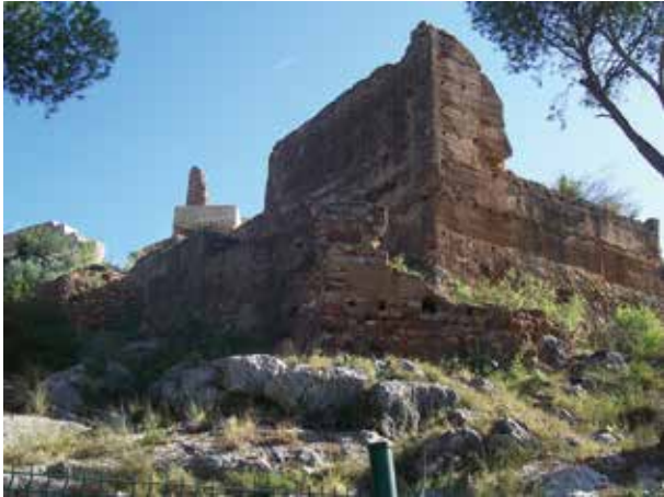
Figura 70. Detall d'una torre del castell abans de la restauració.
