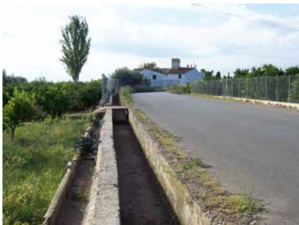
Figura 279. Tram més meridional del Caminàs en la partida de Fadrell, a la vora del molí del Salt.
