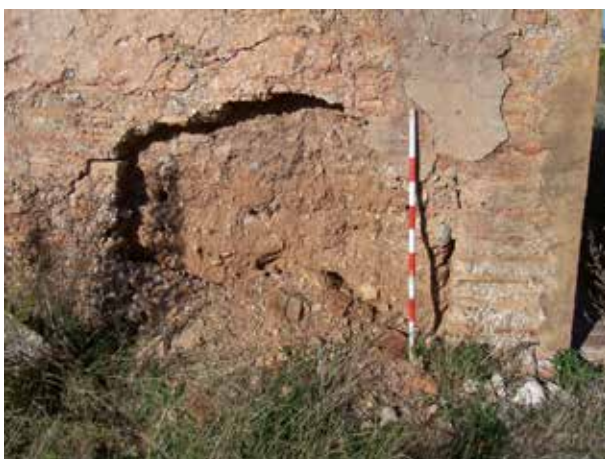
Figura 227. Detall de la tàpia valenciana que té una alqueria en la zona del jaciment.
