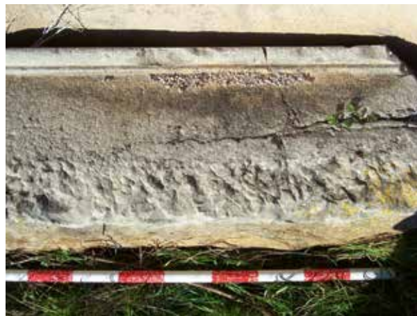
Figura 95. Motllura de pedra tallada, possiblement d'època romana, reaprofitada com a banc.
