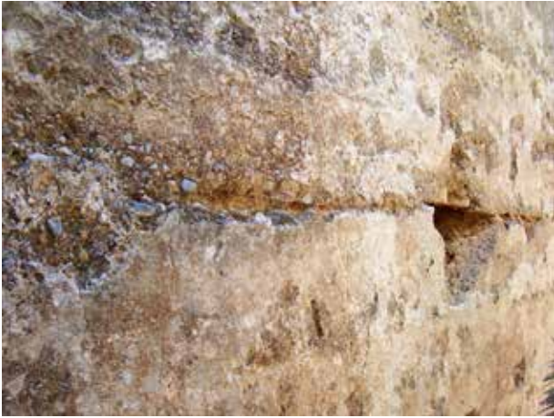
Figura 166. Detall de la fàbrica de tàpia de la torre.
