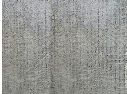
Una pared con malla metálica recubierta con repellado
