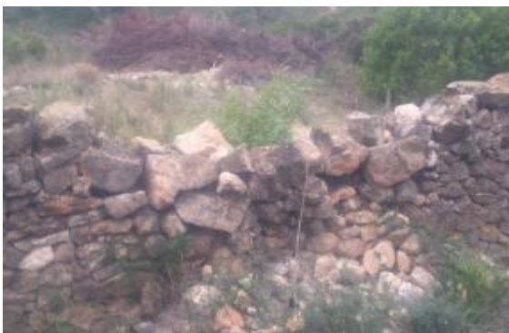
Figura 8 Mampostería ordinaria en seco. Fuente: Autor.
