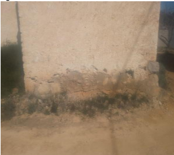
Figura 24 Fachada secundaria del horno. Fuente: Autor.
