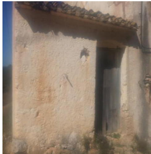
Figura 25 Fachada principal del horno. Fuente: Autor.
