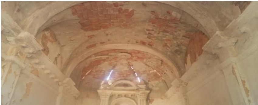
Figura 10 Vista interior, estado de la bóveda. Fuente: Autor.
