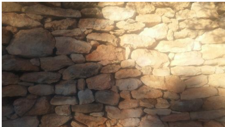
Imagen 1: Aparejo de Mampostería en seco Fuente: Autor
