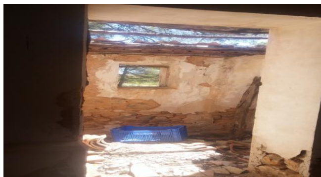
Figura 12 Interior de la sala adyacente. Fuente: Autor.
