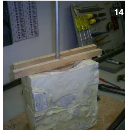
14 Se coloca un tubo para que el macho pueda ser manipulado posteriormente. Se aplica desmoldante QB 10.
