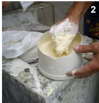
2 Se prepara el yeso piedra con agua, en este momento se elaboraron 4 kilos para la primera cavidad
