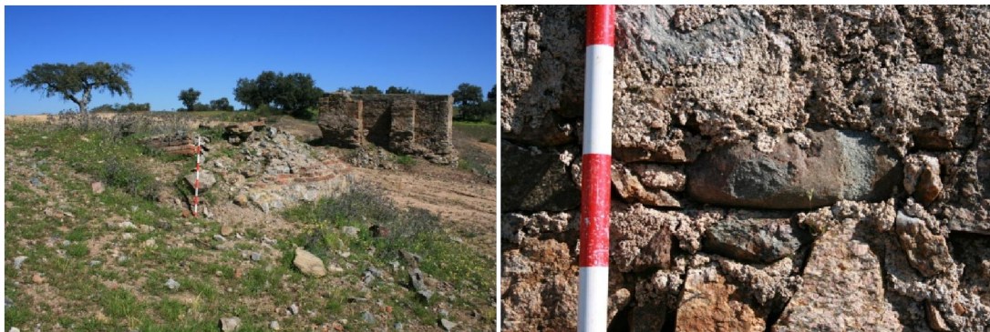
Fig. 15. Las Minillas-1. Pozo 1. Base de maquinaria de ascensor y lado O del pozo (izda) y lado S del pozo, con detalle de la maza utilizada como material constructivo
