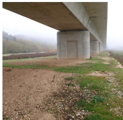
Figura 4.3 - Vista Inferior do Viaduto
