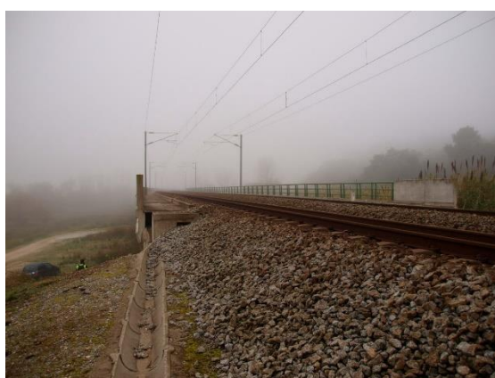
Figura 4.4 - Vista do Viaduto a partir do Encontro Norte
