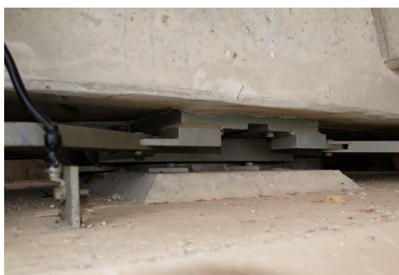
Figura 4.10 – Aparelho de Apoio Móvel [64]
