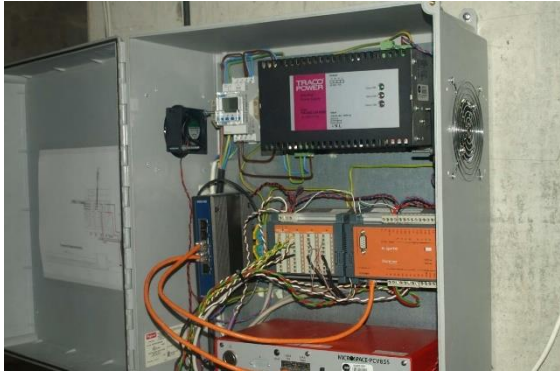
Figura 4.12 – Caixa com computador e subsistemas de aquisição [72]
