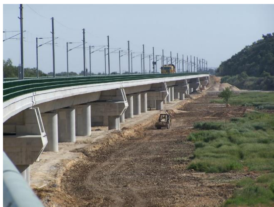
Figura 4.2 - Vista Norte do Viaduto
