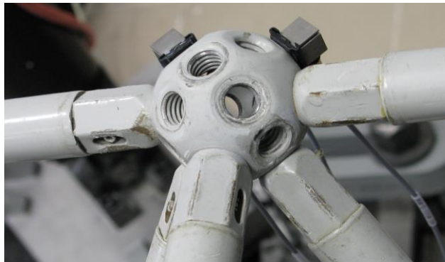
Figura 3.8: Sistema de conexão de nós. Sistema Mero [26].
