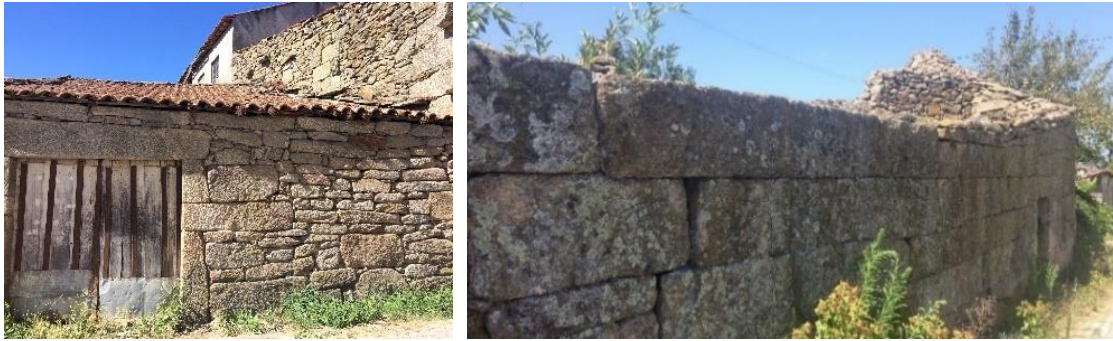
Figura 2.3 - Construções de alvenaria de pedra seca ou mal argamassada, Vilar de Perdizes
