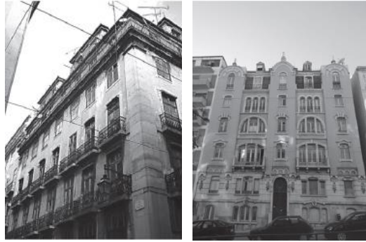
Figura 2.23 - Edifício Pombalino e Gaioleiro onde foram realizados os ensaios in-situ [26]
