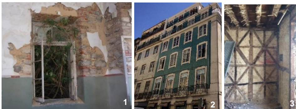
1-Edifício de alvenaria de pedra calcária, basalto e tijolo, Lisboa; 2; 3- Edifício pombalino, alvenaria de pedra e madeira, alvenaria armada, Baixa Pombalina.
