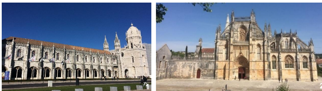
1-Mosteiro dos Jerónimos, Lisboa; 2- Mosteiro da Batalha, Batalha.
