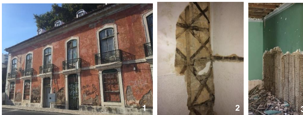
1-Palacete em Odivelas com paredes resistentes em alvenaria de pedra; 2- Frontal com “Cruz de Santo André”; 3- Parede divisória de tabique
