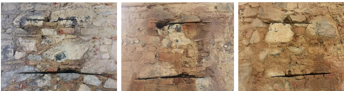
Figura 3.12 - Janelas de ensaio: E1, E2 e E3
