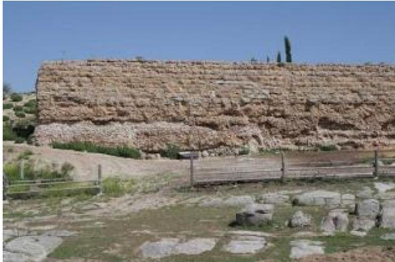
**Figura 2.2 - Ruínas do muro de alvenaria da barragem de Alcantarilla (Aranda Gutiérrez et al., 2003)**
