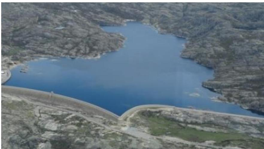
**Figura 2.5 - Barragem da Lagoa Comprida, estrutura de planta poligonal localizada na serra da Estrela (EDP, 2016)**
