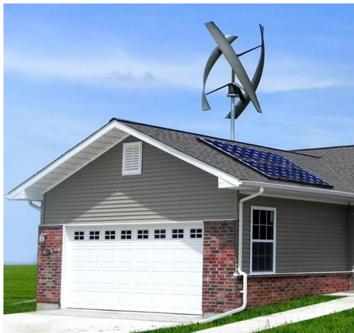
Figura 1.5 - Sistema PV e eólico instalados numa habitação
