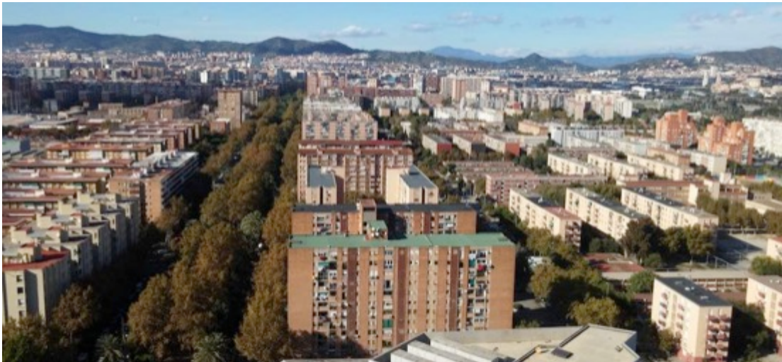
Figura 3.5: Vista 3rea Barrio Bes3s e Maresme la hilera de 3rboles, es la Rambla del Prim. (Fuente: Google maps, Consultafo: 20-06-2017. Disponible en: https://www.google.es/maps/place/Barcelona,+Provincia+de+Barcelona/data=!4m2!3m1!1s0x12a49816718e30e5:0x44b0fb3d4f47660a?sa=X&ved=0ahUKEwjG0qDljNDWAhXJLcAKHcTzAJ8Q8gEIJTAA )
