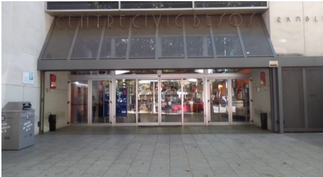
Figura 3.6: Fotografía Fachada Principal entrada Centro Cívico – Foto tomada el 13-06-2017.
