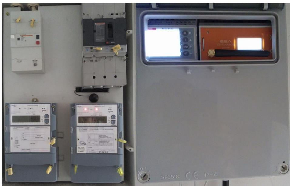
Figura 3.7 – Instalação do analisador de energia
