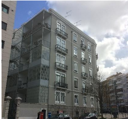
Figura 2.17 – Edifício gaioleiro nas Avenidas Novas, em Lisboa
