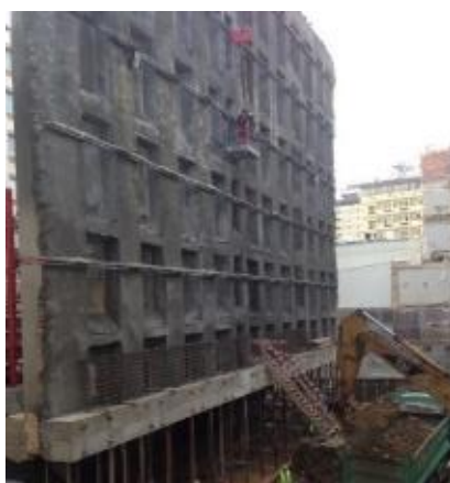
Figura 2.33 – Aplicação da técnica de encamisamento numa fachada de alvenaria ordinária
