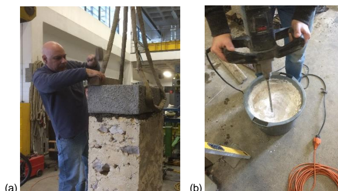
(a) – Assentamento do lintel; (b) – Fabrico da argamassa
