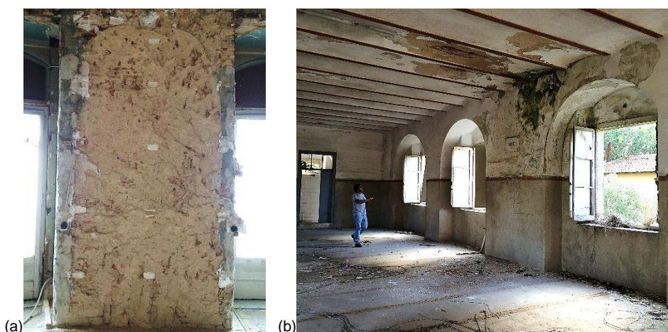
(a) – Nembo de alvenaria ordinária; (b) – Arcos de descarga de vãos; Figura 2.4 – Representação de nembos e arcos de descarga de edifícios de alvenaria ordinária
