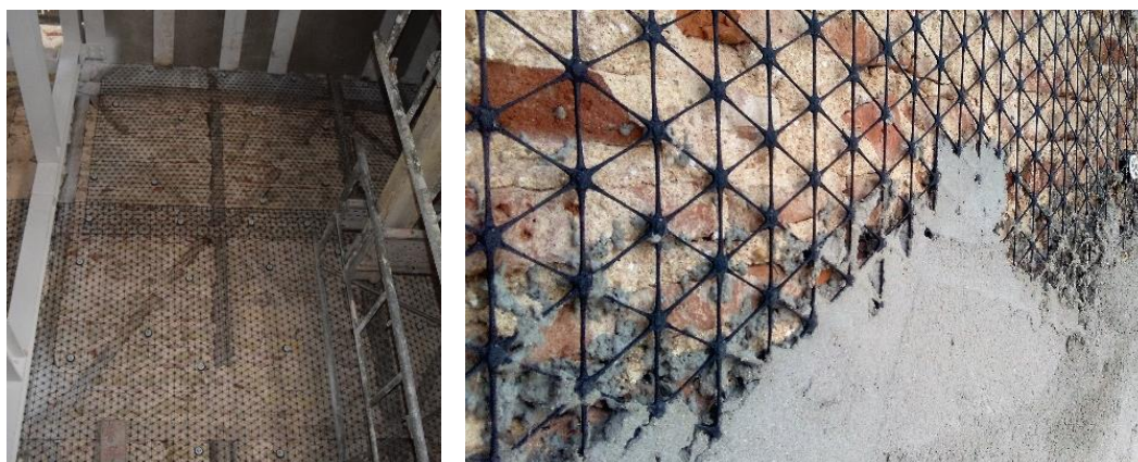
Figura 2.37 – Aplicação do reforço na parede exterior
