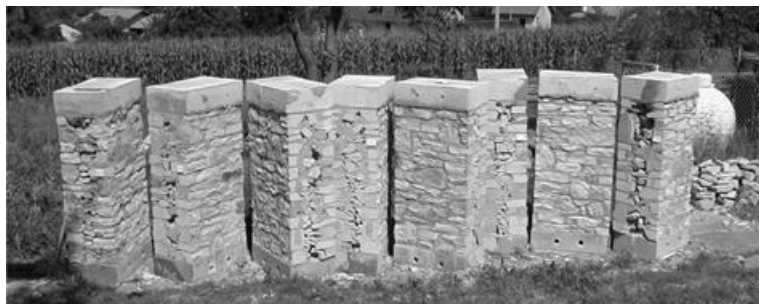
Figura 3.22 – Vista de alguns muretes antes e após a sua construção [76]
