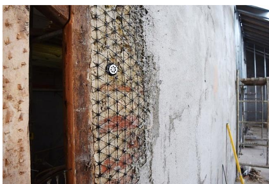
Figura 2.32 – Aplicação de uma rede de polímeros com revestimento de base cimentícia
