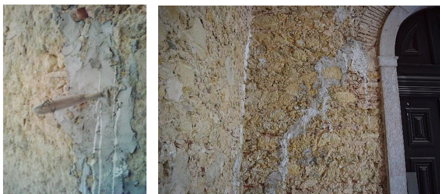
Figura 2.36 – Injeção de calda de cal hidráulica
