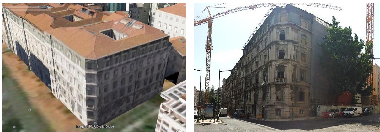
Figura 2.39 – Fachada do edifício antes [Google Earth] e durante a obra
