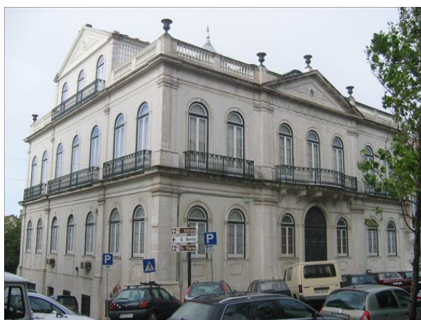
Figura 2.34 – Fachada Norte e Este do Palacete Barão de Santos [29]
