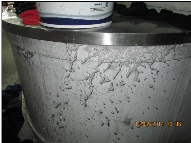
**Figura 27:** Água a sair pelas fendas da tampa do depósito durante a operação de lavagem.
