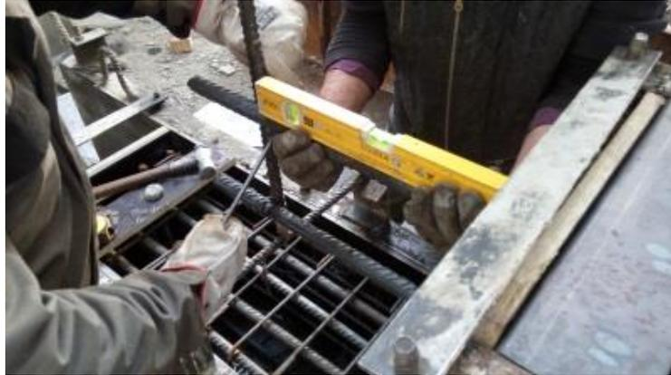
Figura 3.18 - Posicionamento dos Varões na Cofragem
