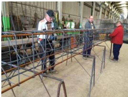
Figura 2.5 - Colocação de Armaduras
