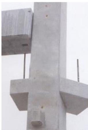
Figura 2.16 - Ligação com Ferrolho e Posterior Preenchimento da Junta (Fernández-Ordóñez, 2015)
