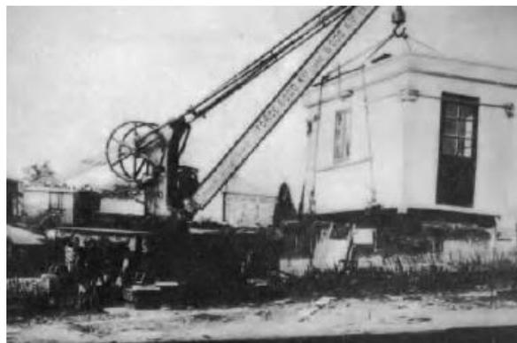
Figura 2.1 - Estrutura Pré-fabricada em 1900 (Bachmann, 2011)
