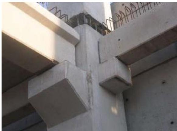
Figura 2.9 - Ligações de Estruturas Pré-Fabricadas (Yuksel, 2012)
