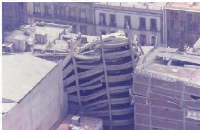
Figura 2.10 - Colapso Progressivo de uma Estrutura (Englekirk, 2003)
