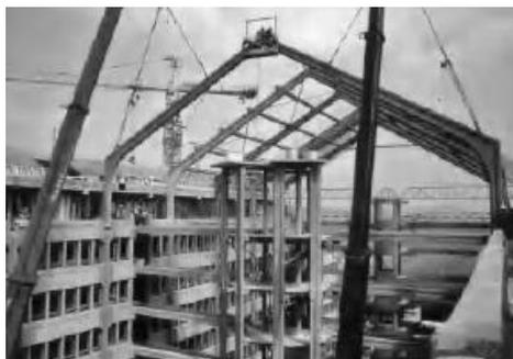
Figura 2.3 - Faseamento de uma Estrutura Pré-fabricada (adaptado de Bachmann, 2011)
