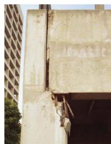
Figura 2.18 - Descasque da Extremidade do Pilar (FIB – Task Group 7.3, 2003)
