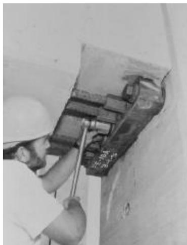
Figura 2.15 - Ligação por Aparafusamento (Englekirk, 2003)
