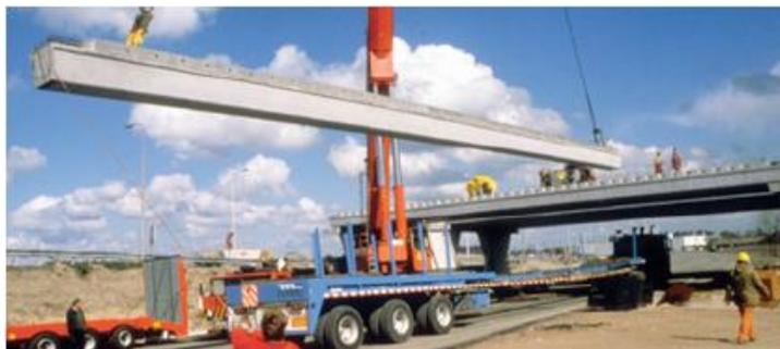
Figura 2.8 - Transporte e Colocação de Viga Pré-fabricada (FIB – Task Group 6.4, 2004)
