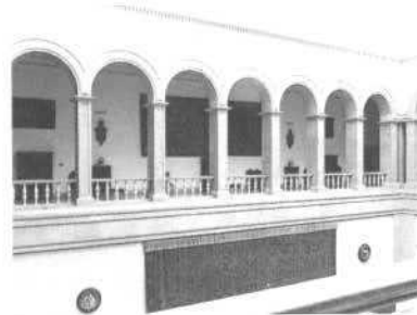
Galerias em loggia sobre a Sala dos Tapetes Persas
