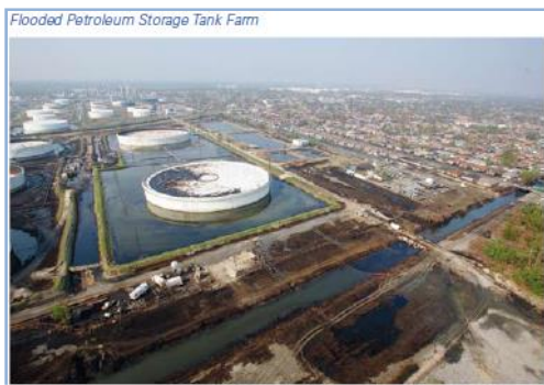
Figura 22 - Inundação de tanques de combustível Fonte: ASCE, 2007, p.6
