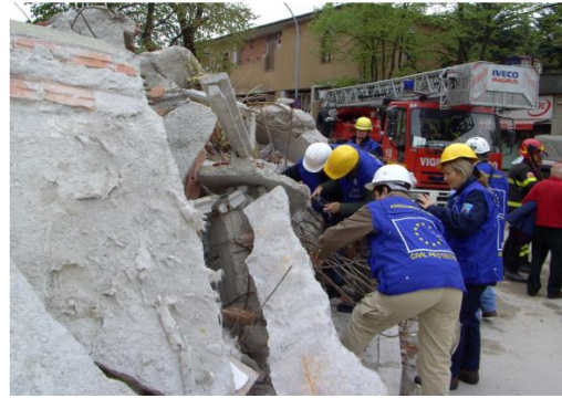
b) – Danos no edifício da prefeitura
