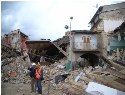
c) - Colapso de edifícios de alvenaria
