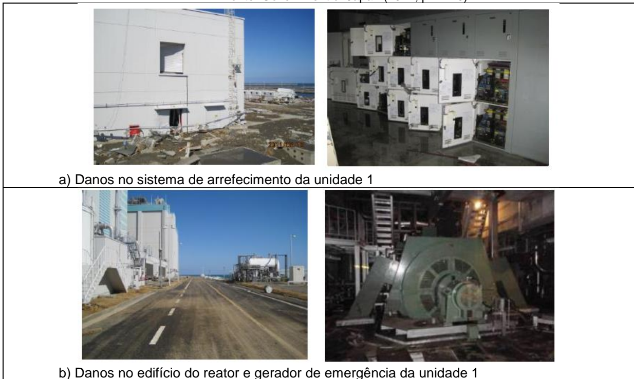
Figura 38 - (a) Danos no sistema de arrefecimento (b) e no edifício do reator e gerador de emergência (unidade 1) na central nuclear de Fukushima Dai-ichi devido ao tsunami Fonte: Government of Japan (2011, p. III-46)
