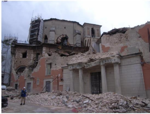
a) – Danos no edifício da prefeitura
