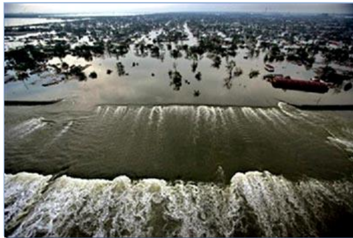
Figura 25 – Rutura nos diques, New Orleans Fonte: ASCE, 2007, p.29
