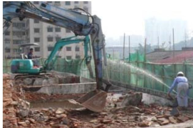
Fig. 4.24- Demolição do piso superior com “pica-pau” e auxílio de retro escavadora
