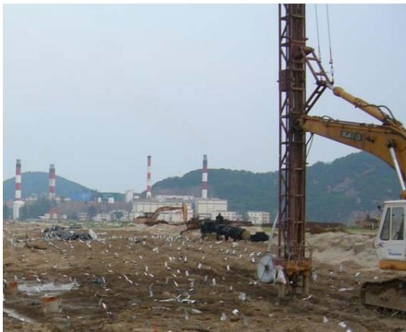
Fig. 4.6- Cravação de drenos verticais em aterros
