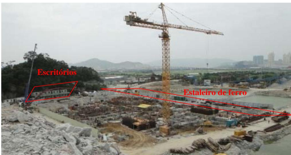
Fig. 5.17 - Vista do estaleiro decorrido um mês de obras com as fundações concluídas, Junho de 2011
