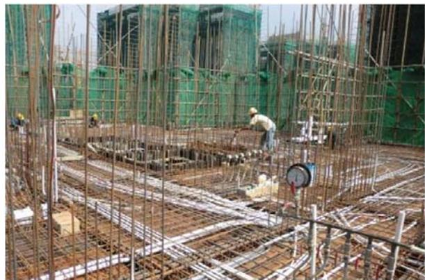
Fig. 4.27– Testes de pressão das tubagens antes da betonagem de laje
