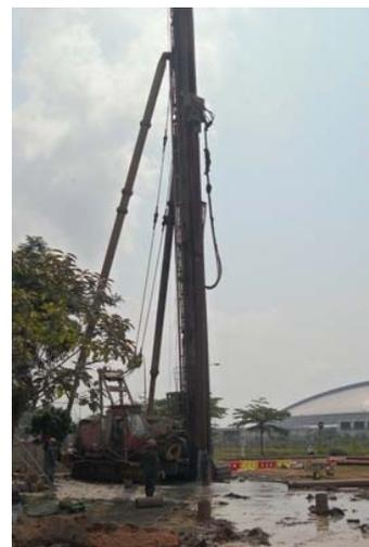
Fig. 4.17– Perfuração com encamisamento
