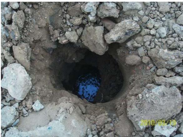
Fig. 4.8- Vista do furo para inserção de drenos verticais logo após perfuração (aparecimento do nível freático)
