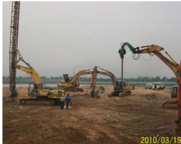
Fig. 4.7- Cravação de drenos verticais à esquerda e auxílio de pré perfuração com agulha à direita
