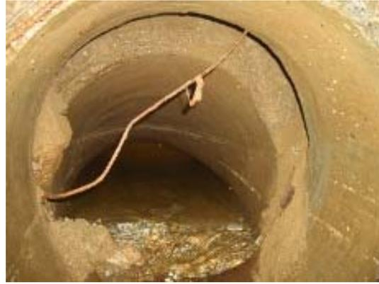
Fig. 4.35 – Rotura de ligação pluvial devido a assentamento diferencial
