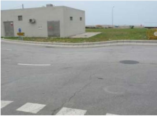
Fig. 4.34 – Arruamento desnivelado devido ao atravessamento de Boxculvert
