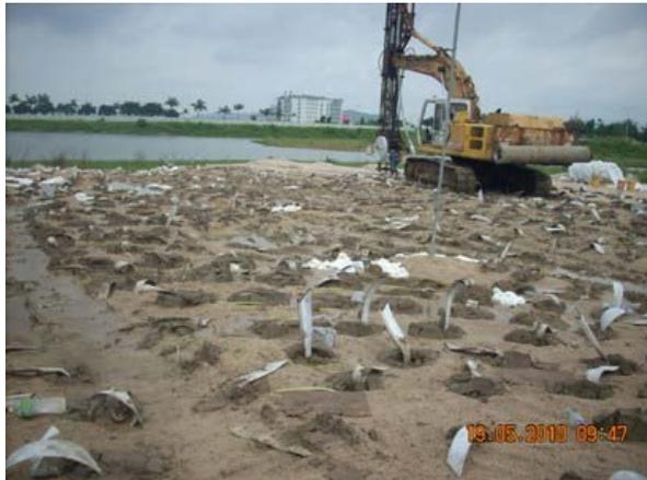
Fig. 4.9- Vista da cravação de drenos verticais sem pré perfuração em aterros recentes no Cotai (observa-se saída de lamas através dos drenos)
