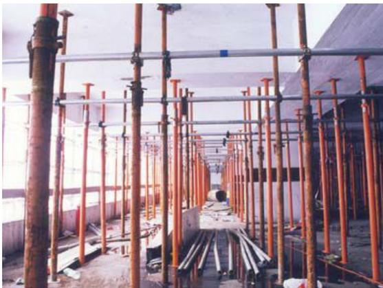
Fig. 4.23– Prumos instalados nos pisos inferiores para suportar cargas de equipamento de demolição [5]
