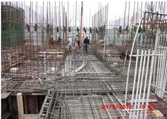
Fig. 4.26– Preparação de laje para betonagem
