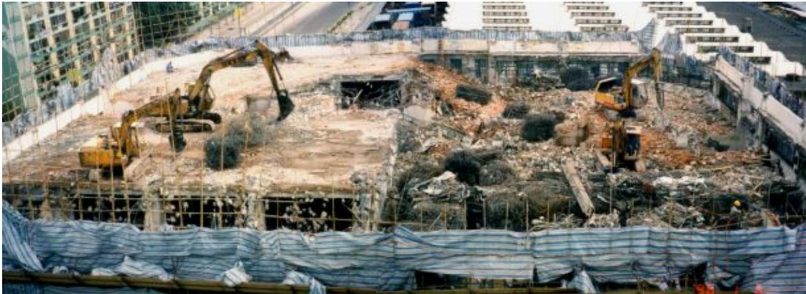
Fig. 4.25– Demolição do piso superior com lançamento dos resíduos em poços de queda [5]
