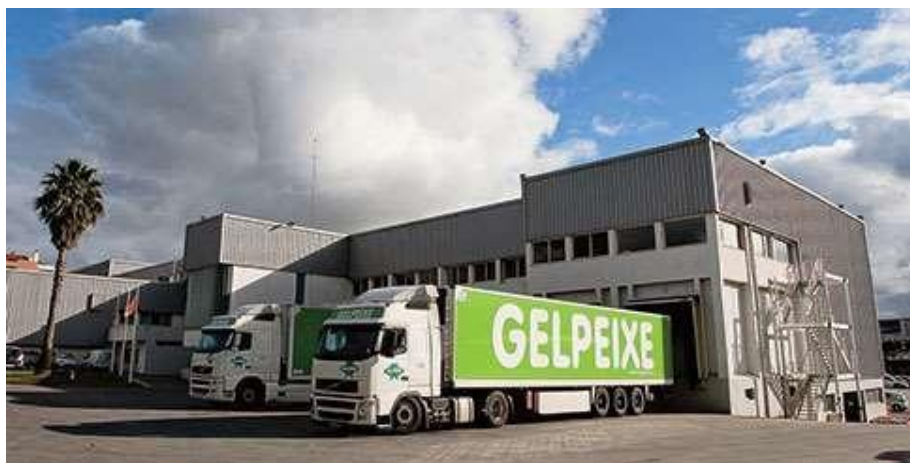
Figura 3.1 - Instalações da Gelpeixe; Área de Cargas e Descargas (fonte: http://economico.sapo.pt/ )
