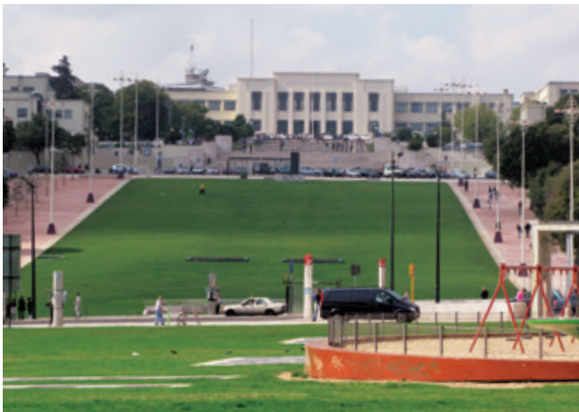
Fig. 1 – Instituto Superior Técnico , Pardal Monteiro, 1935, copyright Jakob Hartmann (2010).
